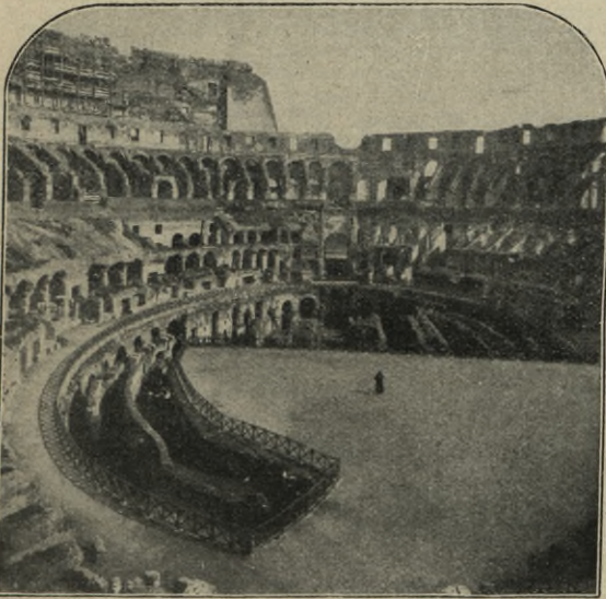
(Nach einer Photographie der Neuen Photographischen Gesellsch. in Steglitz-Berlin.) Abbildung 250. Das Innere des Kolosseums.
