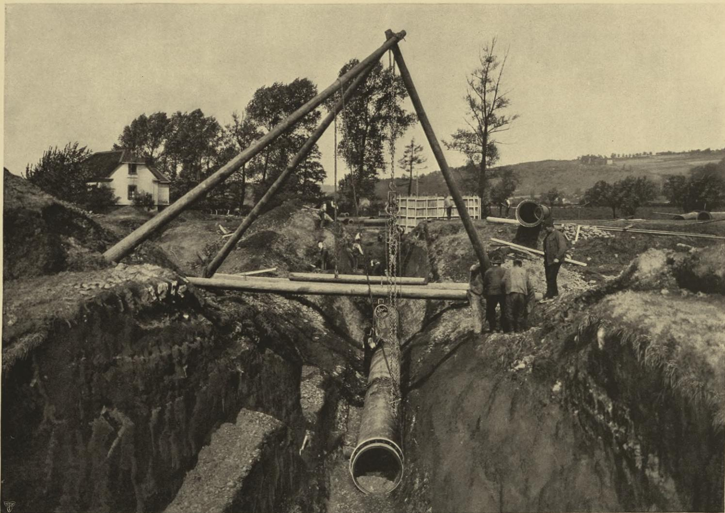
*Verlegung der 800 und 900 mm weiten Dücker durch den Schleusenkanal.*
