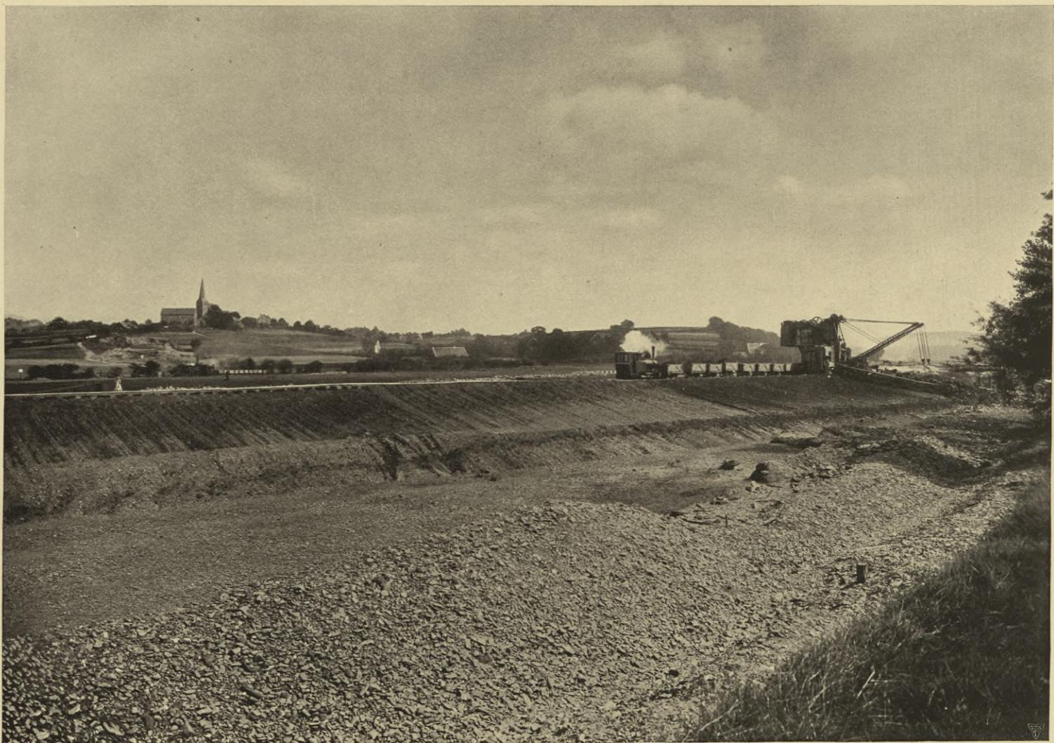
*Baggerarbeiten für die Erbreiterung des Schleusenkanals.*
