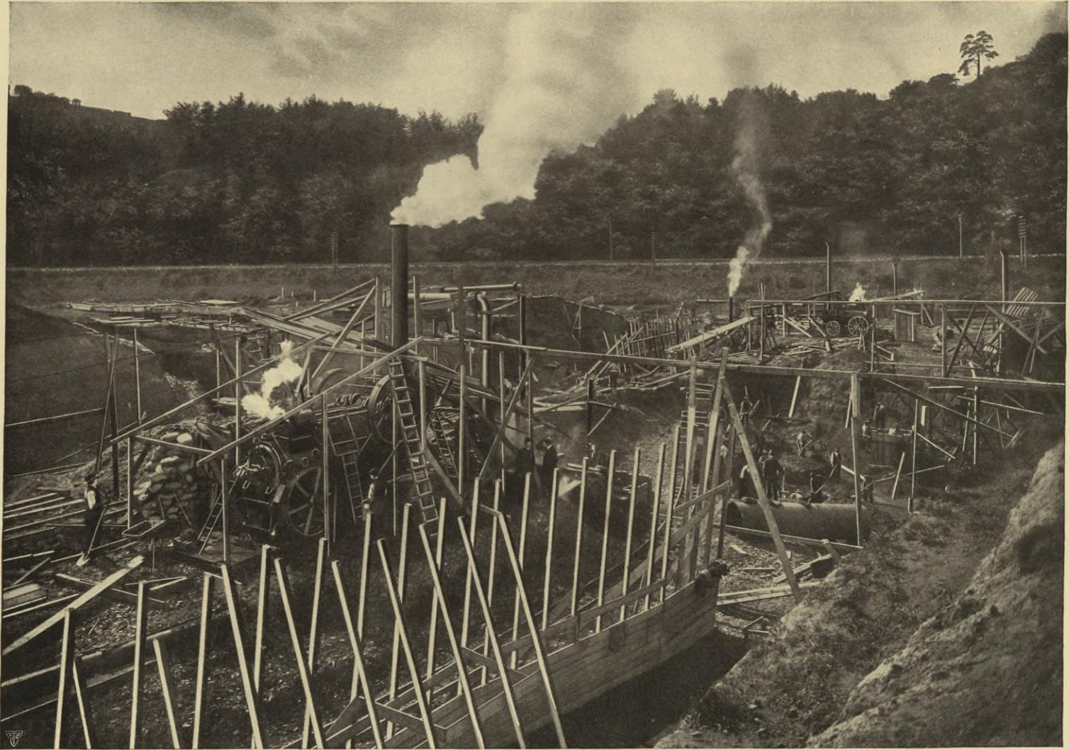
*Herstellung des Ober- und Unterwasserkanals und Wasserhaltung.*
