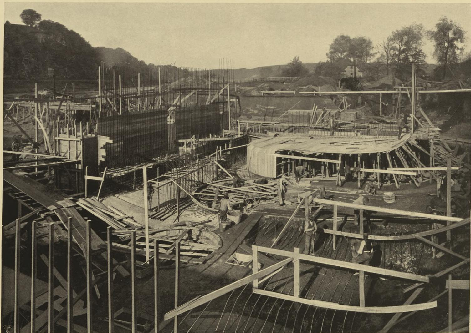
*Eisenbetonarbeiten und Herstellung der Turbineneinläufe.*
