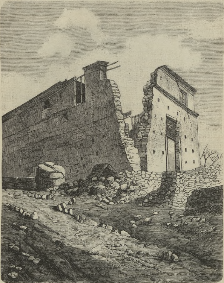
Fig. 3. Die Kathedrale von Paterno in Calabrien nach dem grossen Erdbeben von 1857 (nach MALLET). Die Ecke ist durch einen die Richtung der Wände schief treffenden Stoss herausgeworfen.
