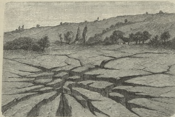
Fig. 13. Radialspalten, entstanden bei dem calabrischen Erdbeben 1783 zu Jerocarne.
