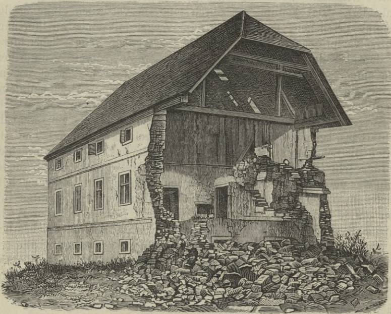
Fig. 39. Schloss St. Nikola. Einsturz gegen N 15^{\circ} W. Nach der von Dr. F. WÄHNER mit Benutzung einer Photographie von Joh. Standl in Agram gegebenen Abbildung.
