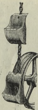
Fig. 1200. Elevatorbecher mit Kette (Paucksch).
