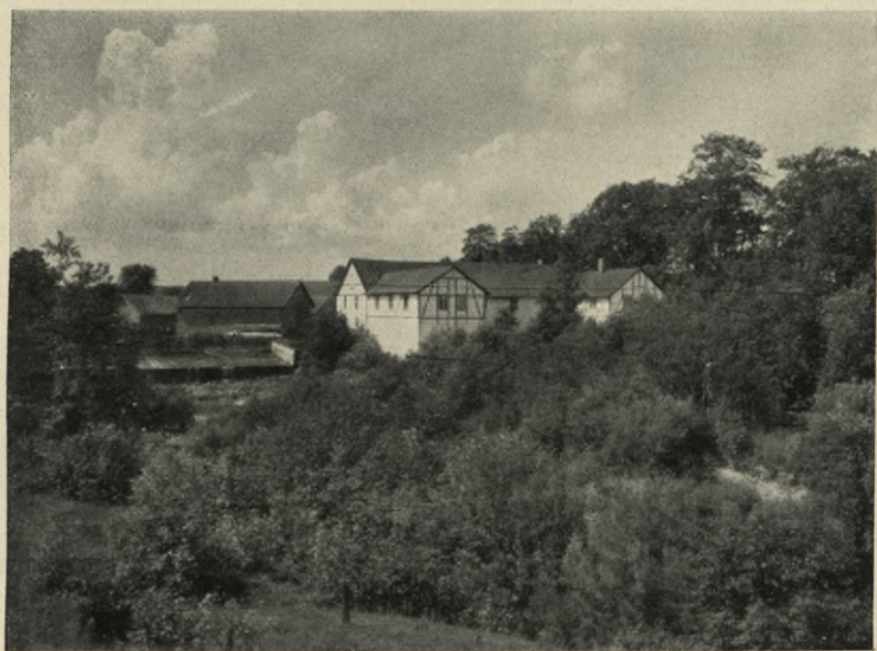
106. Mühle bei Doblen
