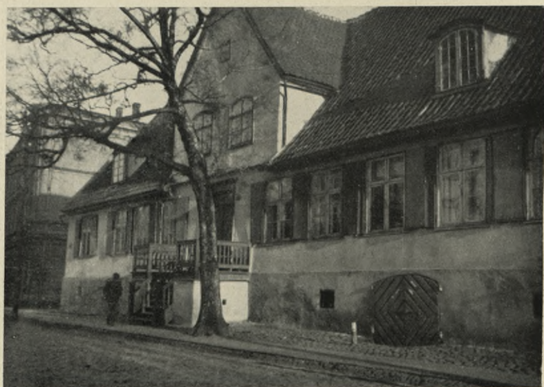
150. Lübau: Haus Johannsen, Waisenhausstraße; erbaut 1782
