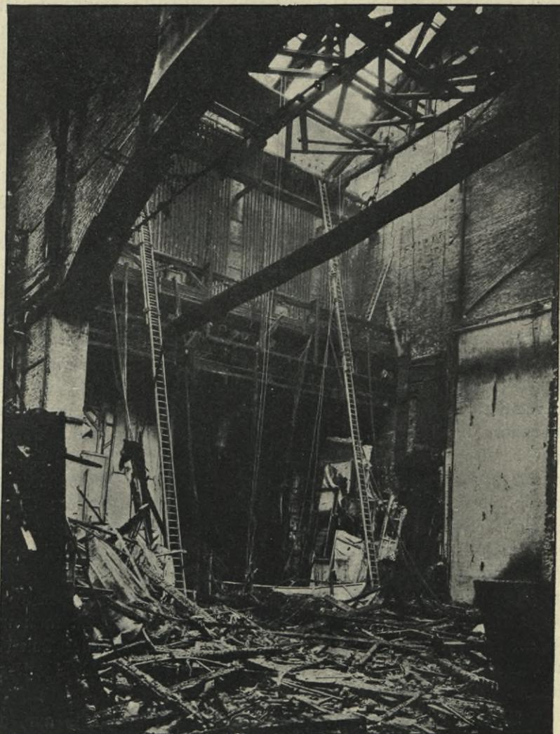
Fig. 3. Hölzerne Dachkonstruktion des Drury Lane-Theaters in London nach einem Bühnenbrande.
