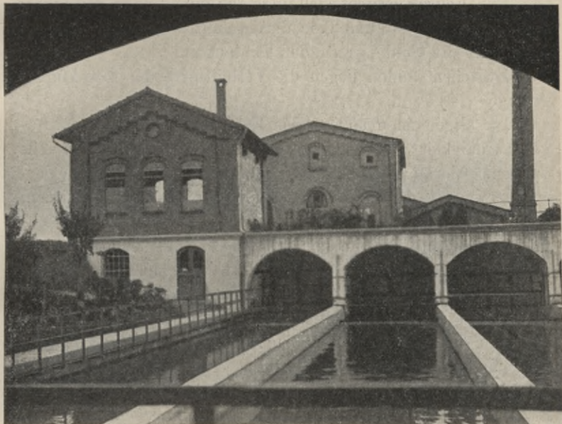
Kassel. Mechanische Kläranlage. Auslauf.
