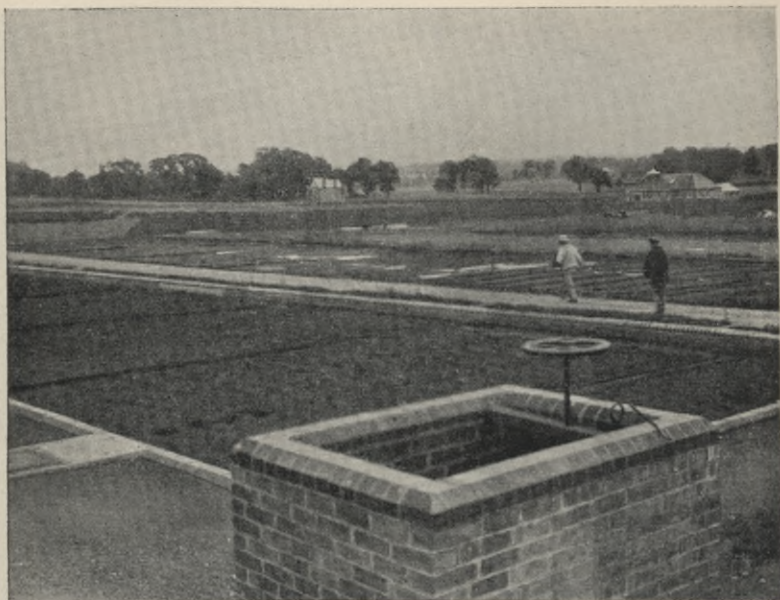
Sutton. Blick auf die Oxydationsfilter II. und III. Ordnung.
