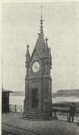
Pegelhäuschen in Cöln a. Rhein.
