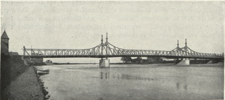
Die Oderbrücke bei Ohlau.
