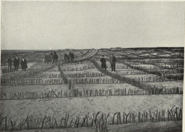
Kiefernbesteck zur Festlegung der Wanderdünen zwischen Süderspitze und Schwarzort.
