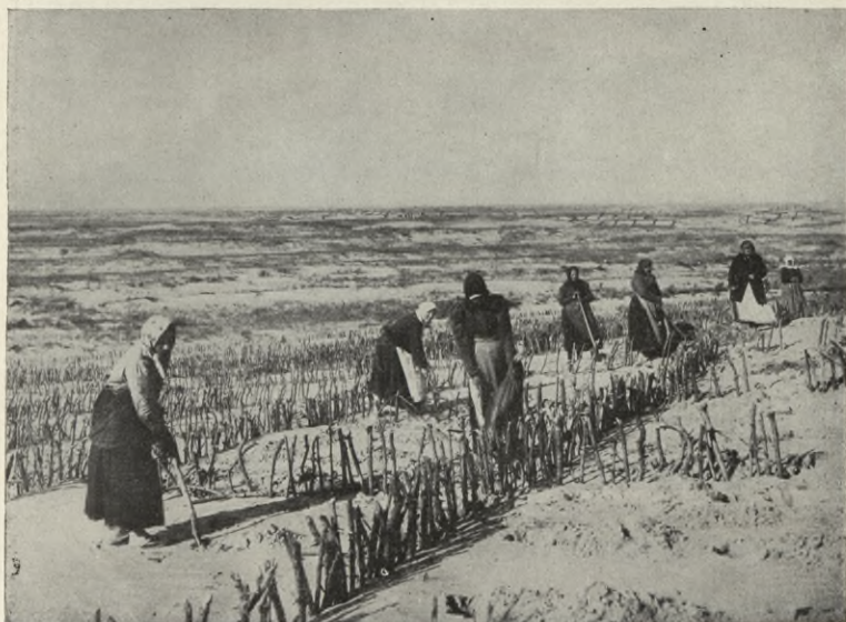
Einbringen des Dunghodens auf der Wanderdüne zwischen Süderspitze und Schwarzort.
