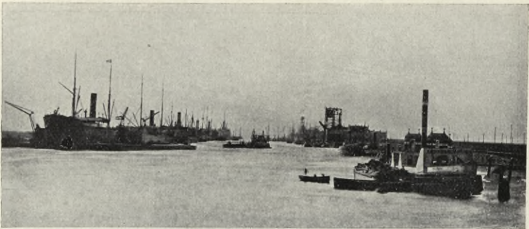
Der Außenhafen in Emden.
