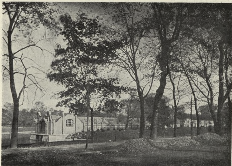
Versuchsanstalt für Wasserbau und Schiffbau in Berlin.
