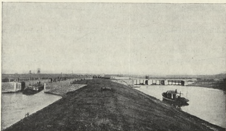
Die Staustufe bei Dratzig an der Netze.
