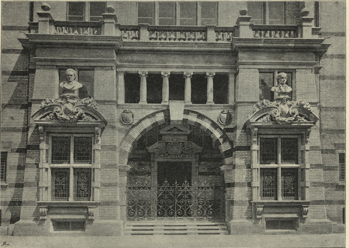
Fig. 9. Hirschengrabenschulhaus Zürich. Ansicht des Haupteinganges.
