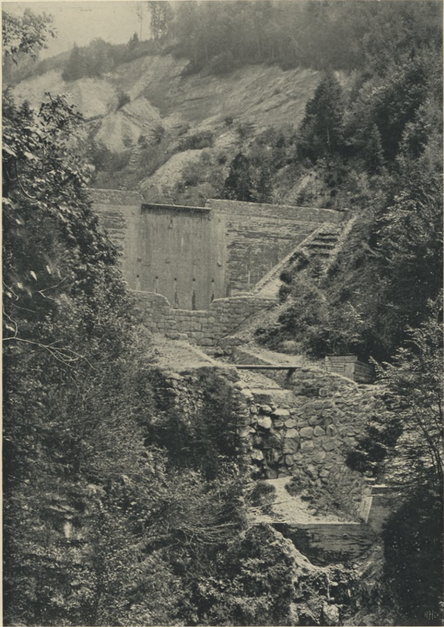
Ansicht der großen Sperre und des Erosionskessels Vue du grand barrage et du bassin d'érosion
