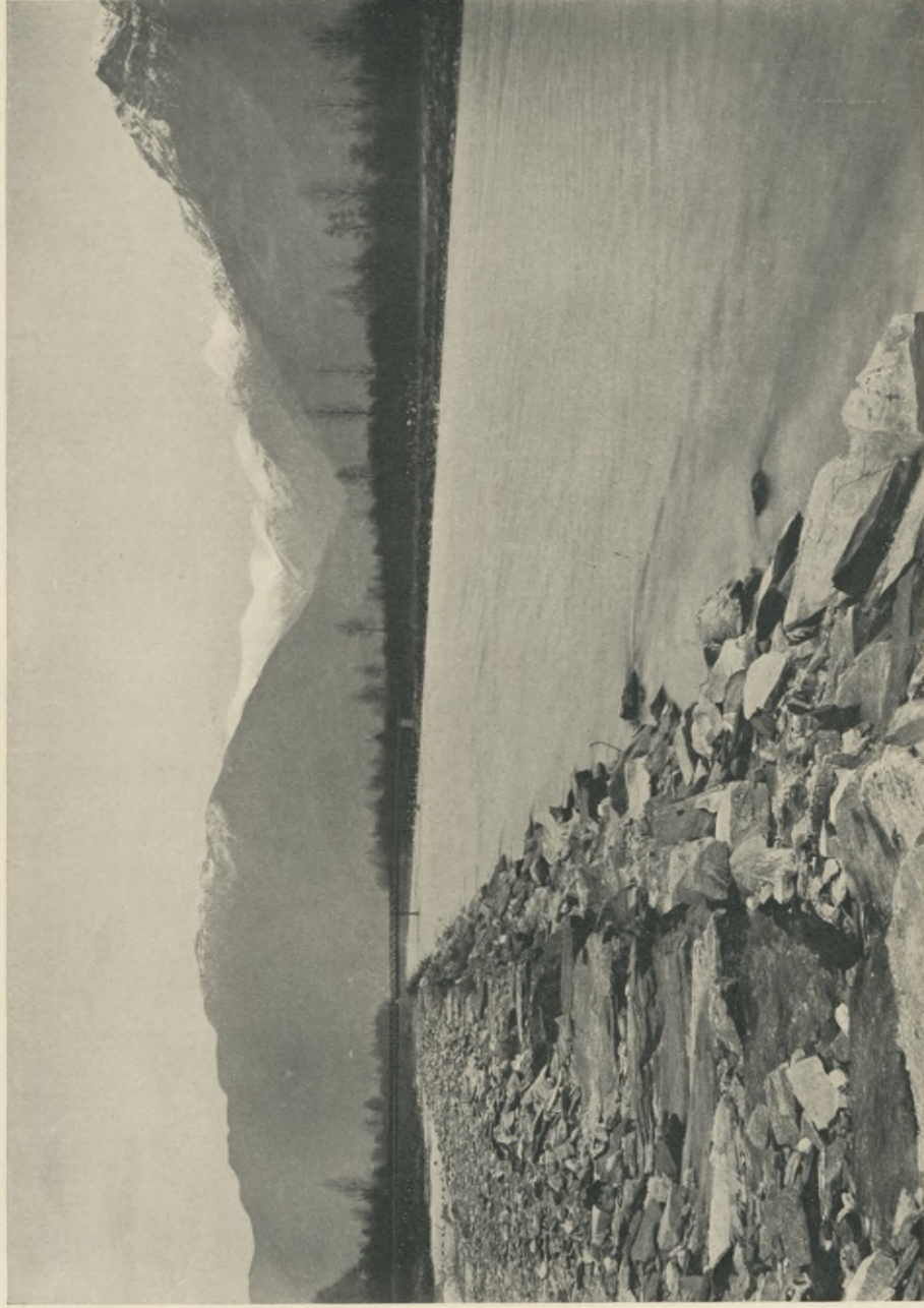
Überströmbares Wuhr aus großen Blöcken bei Gudo Digue submersible en gros matériaux près Gudo
