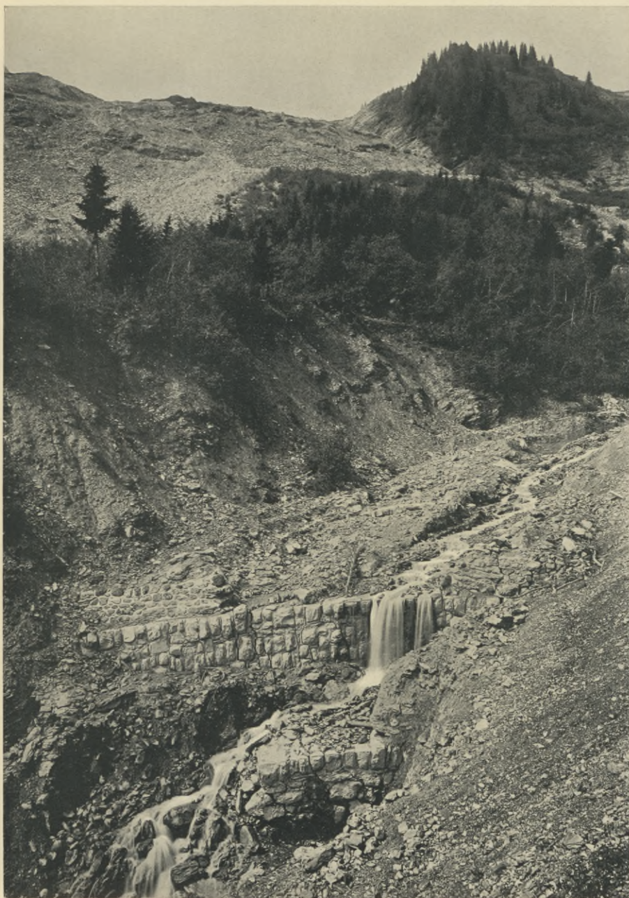
Druckwirkung infolge des Bergsturzes von Masügg auf die Sperren in der Grube Effets de pression produits sur les barrages de la Grube par le glissement de Masugg
