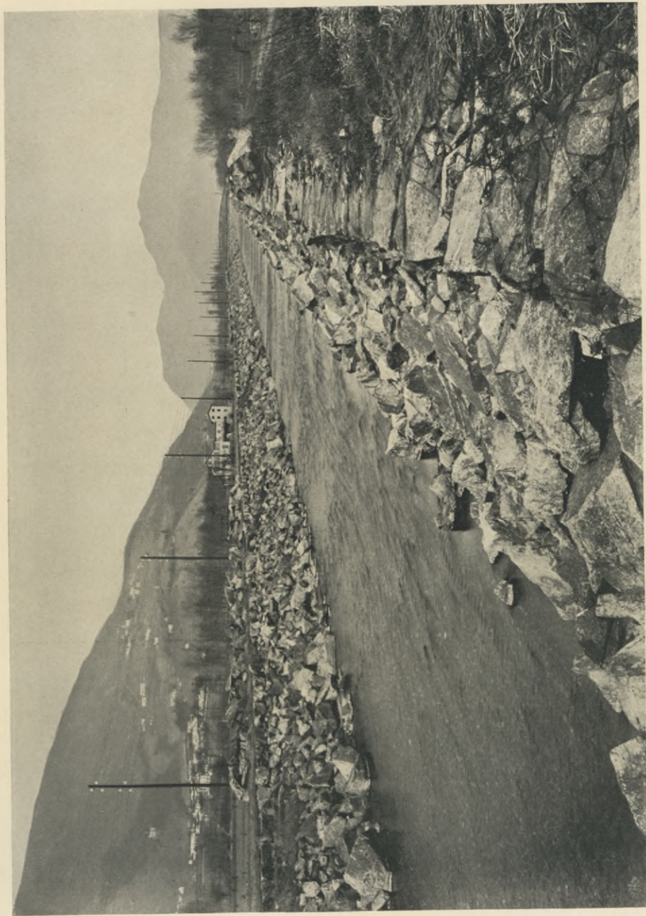
Rollwahr mit regelmäßig gelegten Deckelsteinen
