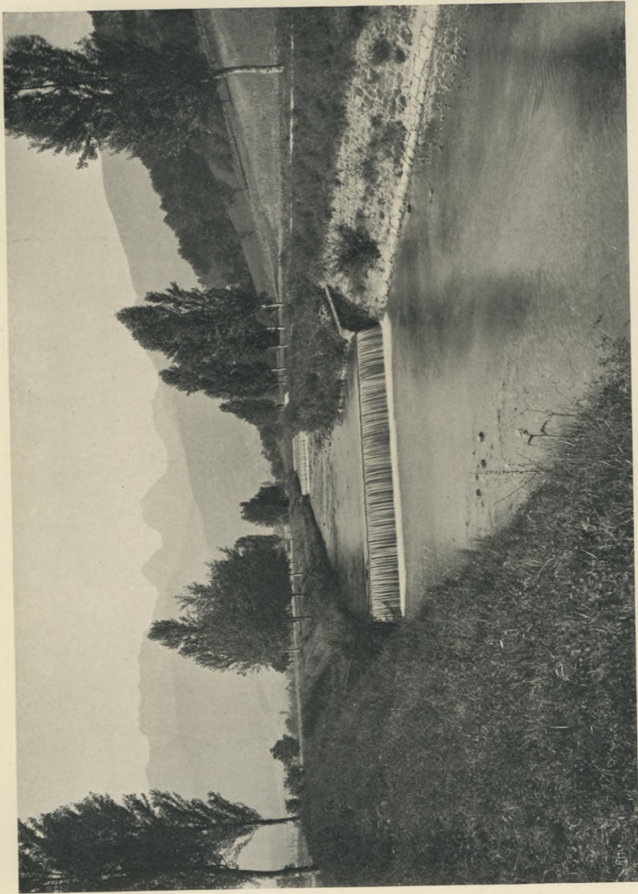
Korrektion des untern Lautes mit Überfällen Correction du cours inférieur avec chutes
