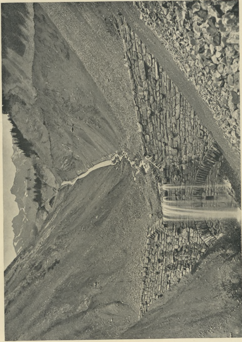
Sperre Nr. 5 und Schale Barrage No 5 et cunette maçonnée
