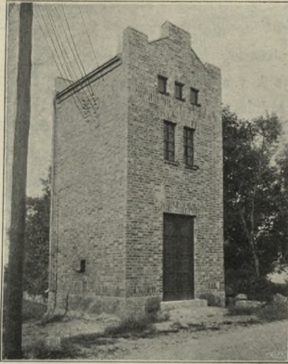
Fig. 88. Tertiärstationen i Vårgårda, exteriör.
