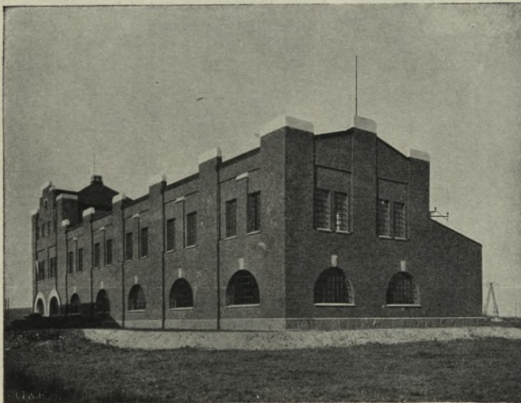
Fig. 65. Sekundärstationen vid Göteborg, exteriör.
