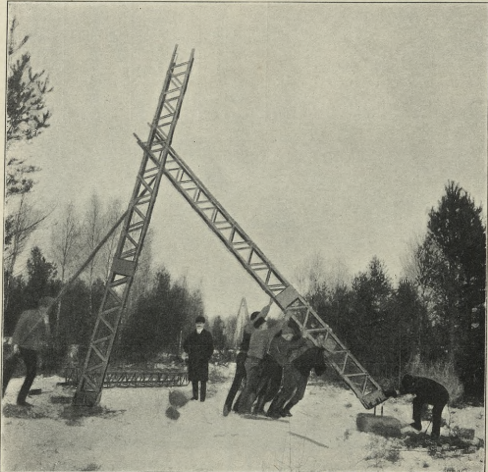
Fig. 53. Göteborgs-linjen, montage af bärmast.
