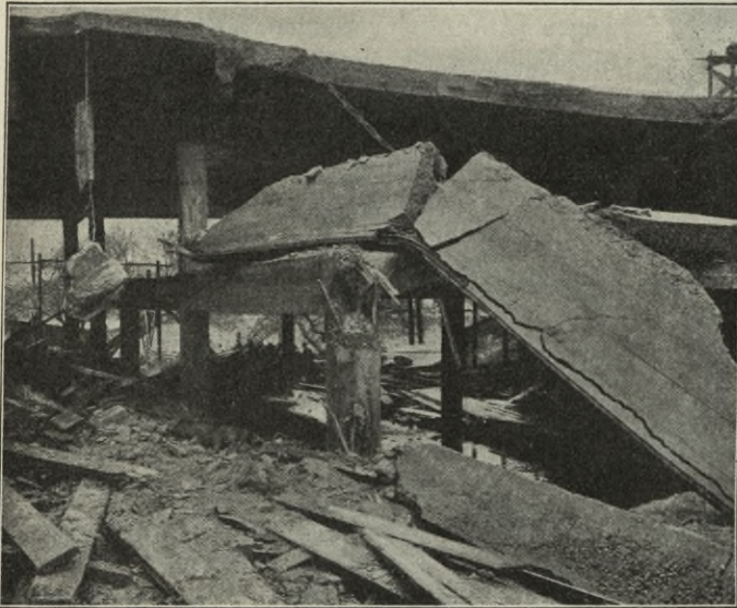
Abb. 50. Vom Einsturz der Fabrik der Kodak Co. in Rochester.
