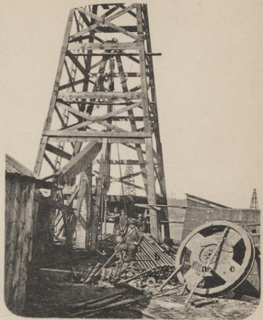
Fig. I. Innere Ansicht eines Ölbohrturmes bei Oil City während des Einsetzens des Bohrgeräthes.
