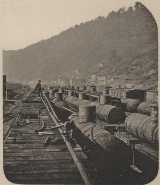
Fig. IV. Verladen des Petroleums aus den Röhrenleitungen in die Eisenbahnfasswagen im Bahnhof bei Oil City.
