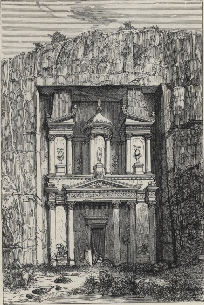
Abb. 532 Grabfassade zu Petra
