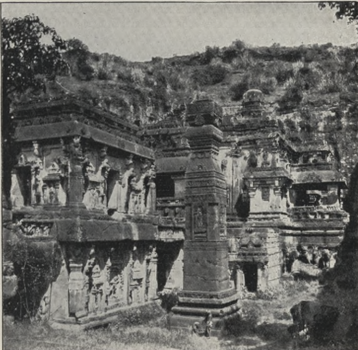
Abb. 137 Ansicht der Kailasa-Grotte zu Ellora
