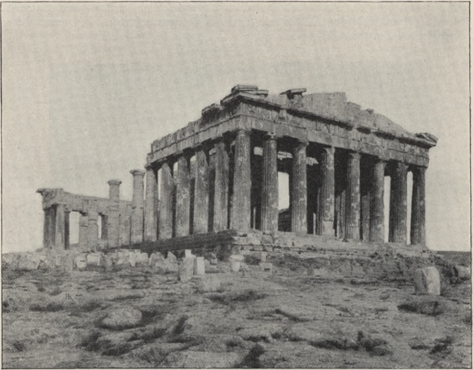
Abb. 246 Der Parthenon in seinem heutigen Zustande von Westen
