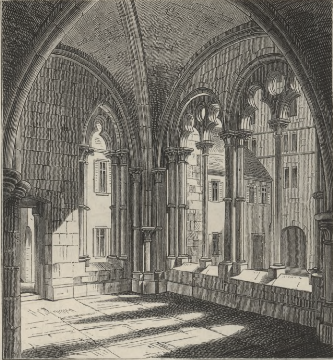
Fig. 454. Vorhalle zu Maulbronn. (C. Riefs.)
