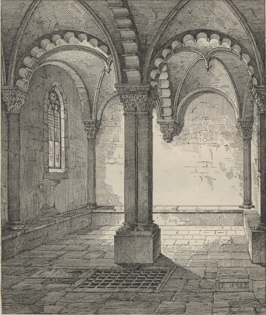
Fig. 439. Schlofskapelle zu Freiburg a/U. (Nach Puttrich.)
