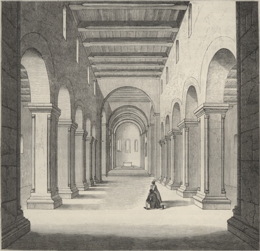
Fig. 394. Inneres der Klosterkirche auf dem Petersberg bei Halle. (Nach Puttrich.)
