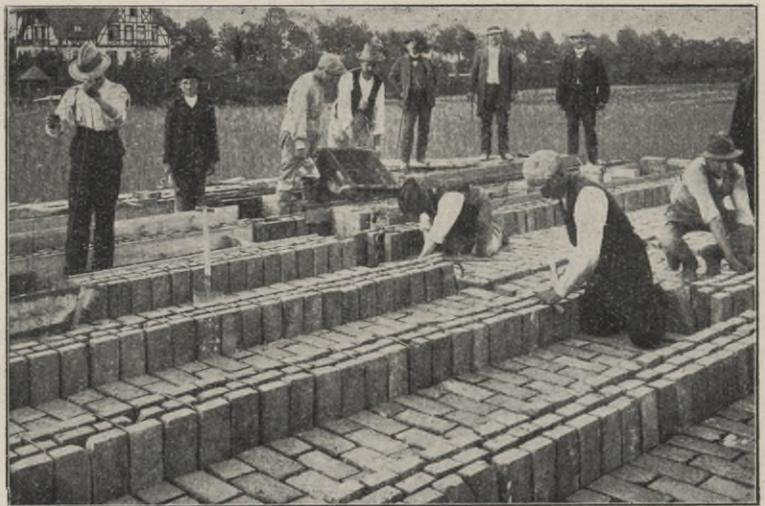
Abb. 109. Fertig verlegte Normalziegeldecke.
