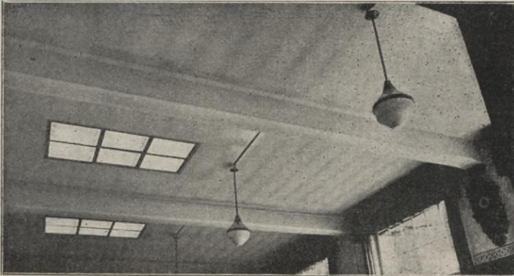
Abb. 1. Putzstreifenbildung einer Hohlsteindecke infolge ungenügender Betonisolierung durch zu schwache Steinnasen.
