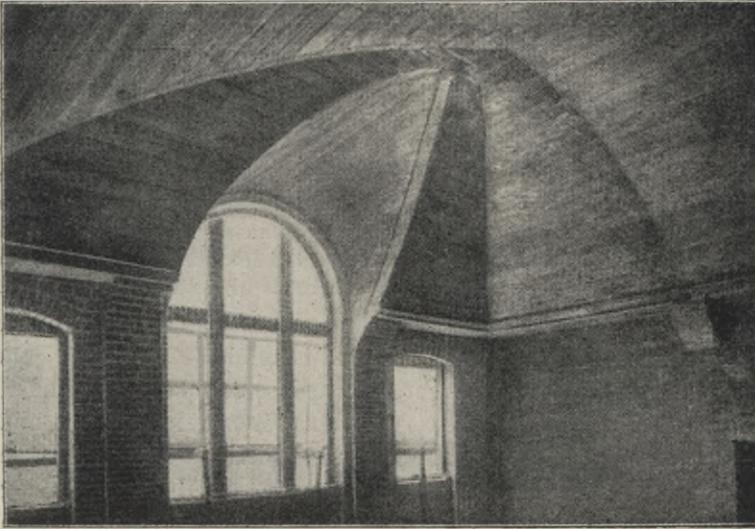
Abb. 10. Drahtspiral-Eisenbetondecke bei einem Schulhause in Berlin.
