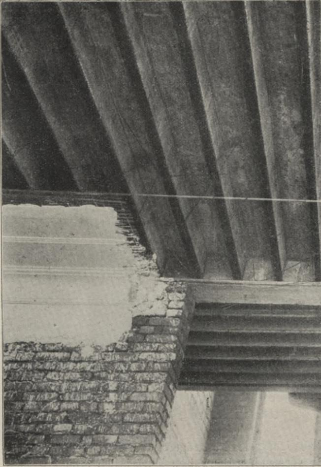
Abb. 27. Ausgeschaltete Hohldecke mit Wellpappenschalung.
