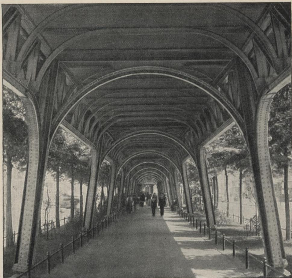
Abb. 94. Schräge Stellung der Viaduktstützen der Berliner Hochbahn.
