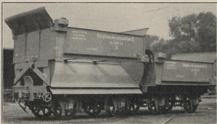
Abb. 145. Selbstentlader mit flachem Boden.
