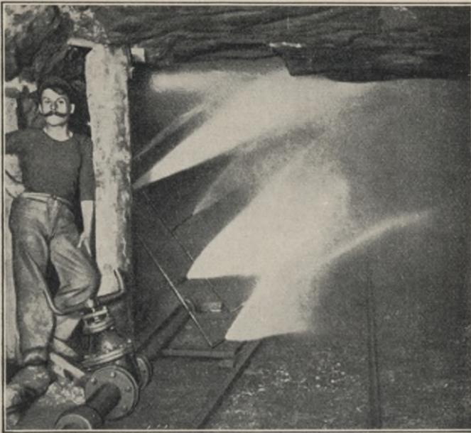
Abb. 98. Strahlapparate für die Stollenlüftung des Simplontunnels.
