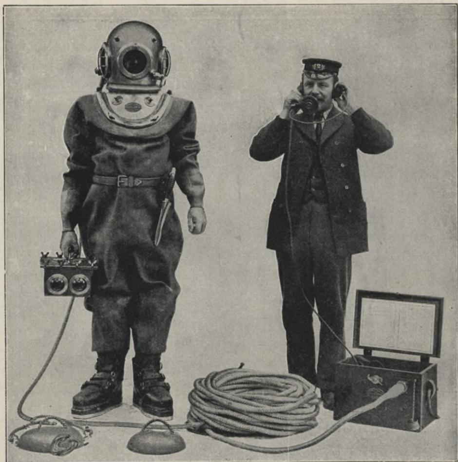
Abb. 370. Eine vollständige Taucherausrüstung mit Telephon und elektrischer Lampe.
