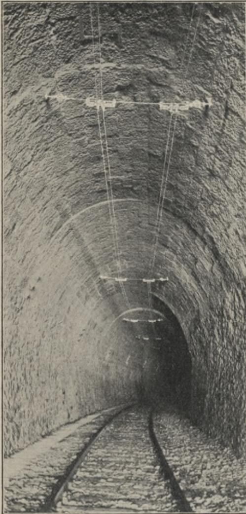
Abb. 173. Die Kontaktleitung des Simplontunnels.
