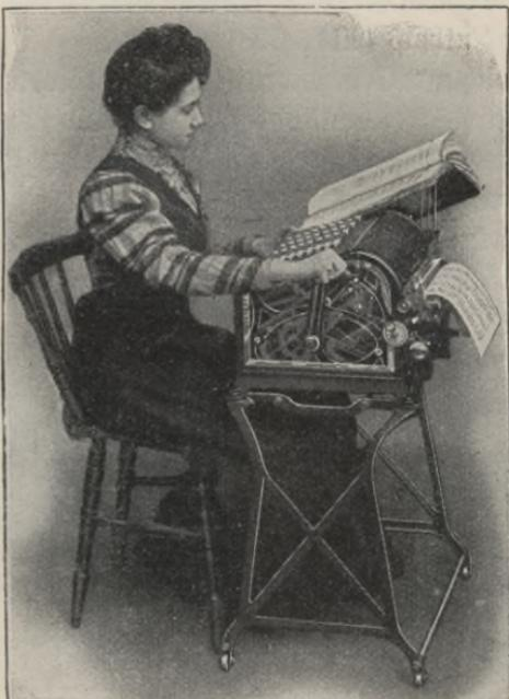
Abb. 700. Additionsmaschine von Burroughs. Siegeslauf der Technik. III.
