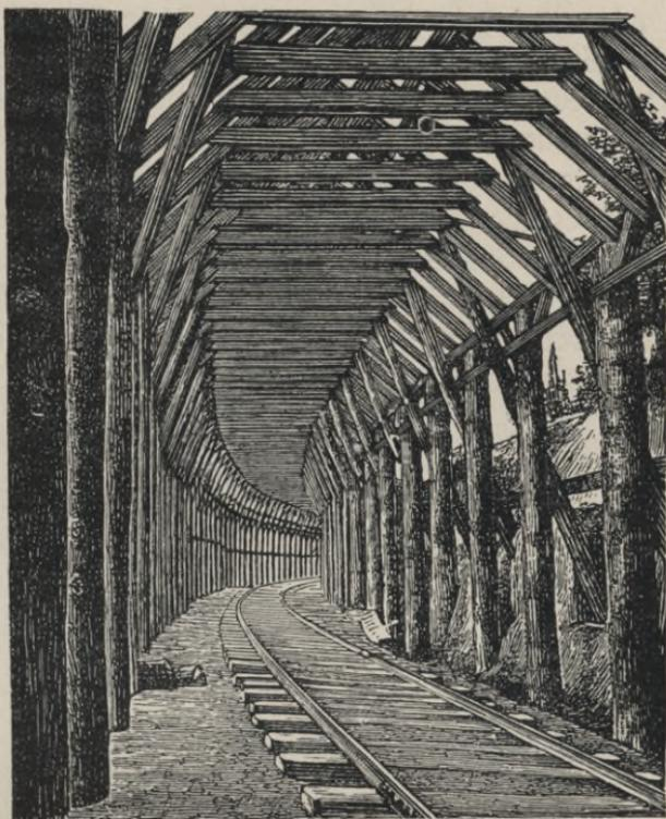
Abb. 47. Schneedach zum Schutze der Eisenbahnen.
