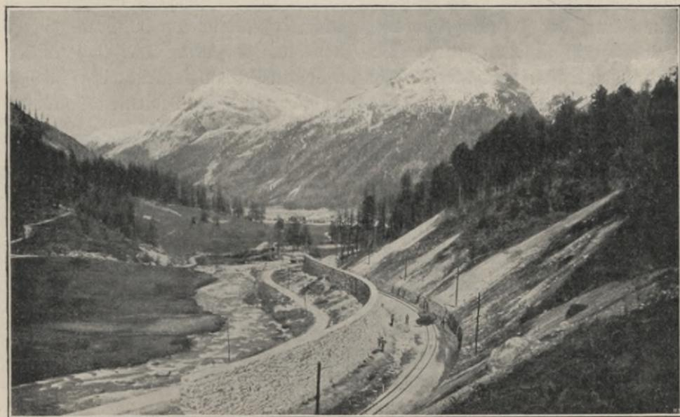
Abb. 48. Lawinenschutz der Albulabahn oberhalb Bevers.
