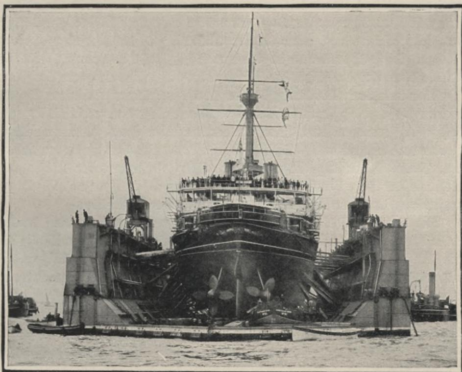
Abb. 374. Das Panzerschiff gehoben und fertig zur Reparatur.
