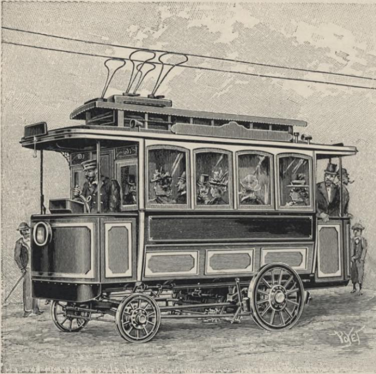
Abb. 224. Elektrischer Omnibus mit Oberleitung.
