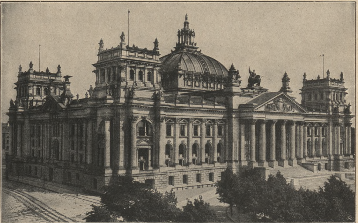
Fig. 16. Das Reichstagsgebäude, 1884—1894 von Wallot im Stil italienischer Hochrenaissance erbaut. Im Kellergeschoß Rustika, die beiden Geschosse darüber durch korinthische Säulen zusammengefaßt. Die ganze Baumasse durch die vier Ecktürme und die über dem Sitzungssaal emporsteigende Glaskuppel zu einem einheitlichen Ganzen verbunden.
