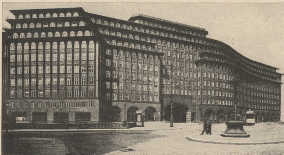
Fig. 30. Fritz Höger, Das Chilehaus in Hamburg, 1923.
