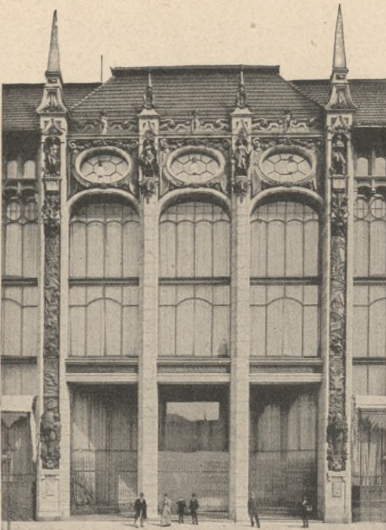
Fig. 27. Warenhaus Wertheim. Mittelteil.
