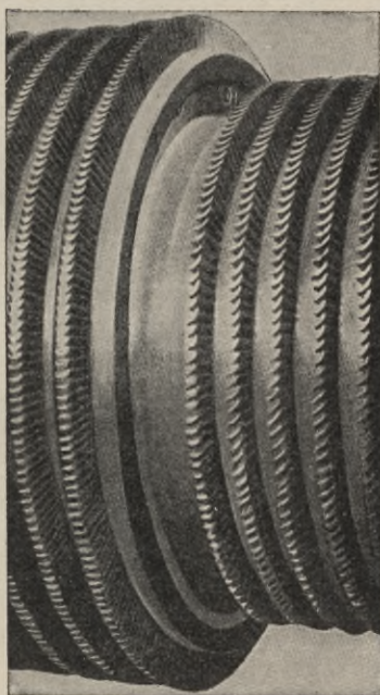
Fig. 324. Laufräder der Melms & Pfenniger-Turbine.
