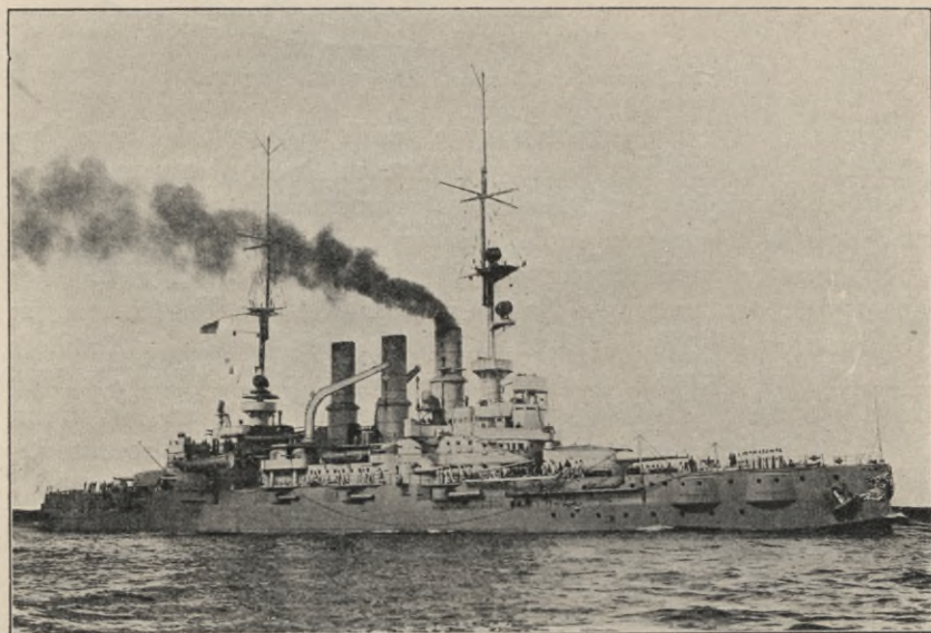
Fig. 92. Linienschiff „Deutschland“. 1905—1906. 13 200 t. 19,3 Kn.
