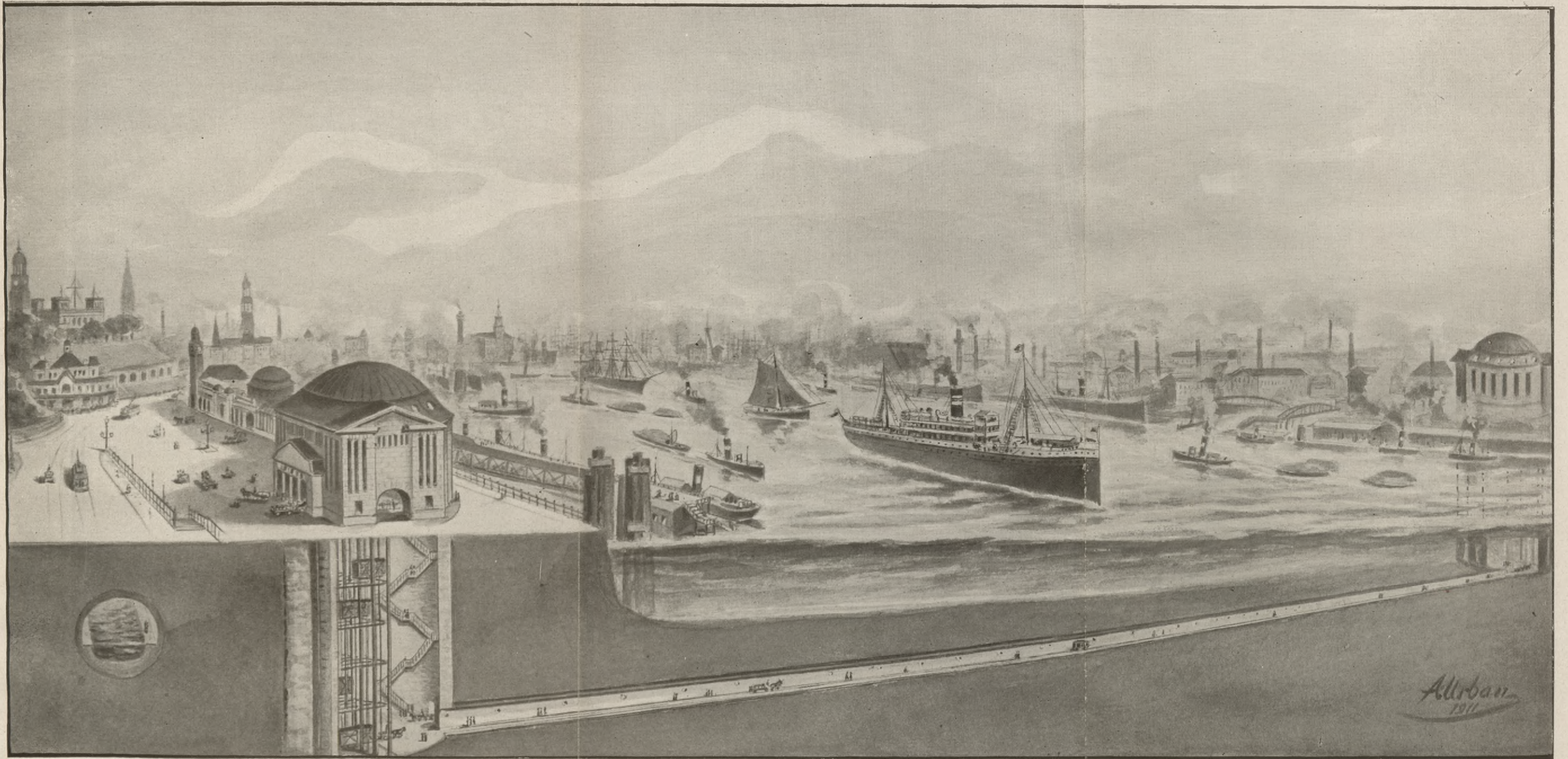
Der Elbtunnel in Hamburg.
