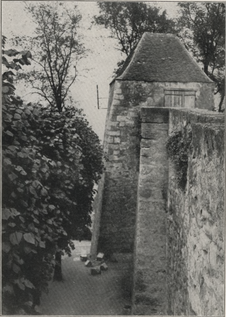
Partie am Wall.
