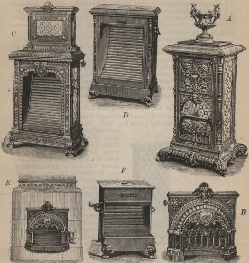
A u. B Asbest-Flammkamine. C—F Kamine nach Wibauw-System. (C mit Aufsatz event. Wärmeschränken. D in einfacherer Ausführung. E als Einsatz in Kachelöfen. F mit Kochloch.
