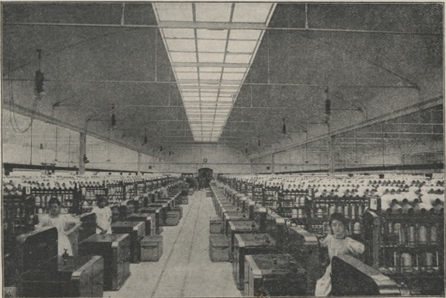
Fig. 62. Großer Spinnereisaal. Oberlicht. Keine Tragsäulen. M. A. N.-Werke.
