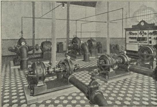
Fig.-27. Das Innere einer Pumpstation (ausgeführt von Bopp & Reuther-Mannheim.)
