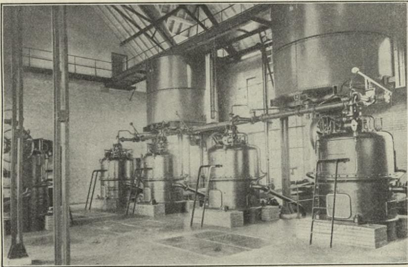
Fig. 96. Schlamm Schleuderanlage in Frankfurt a. M.
