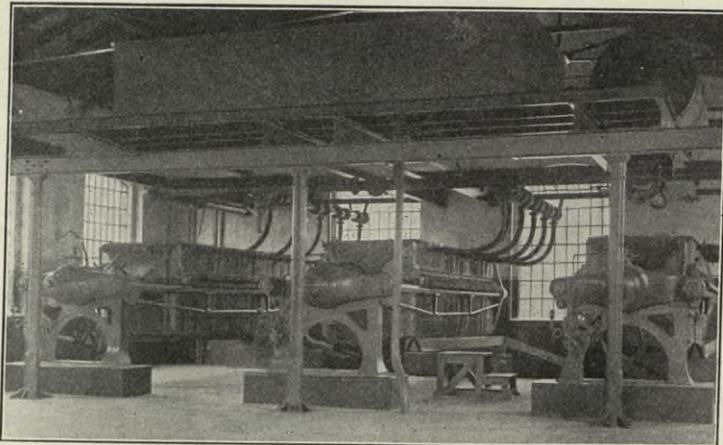
Fig. 94. Ansicht des Schlammpressenraumes der Kläranlage in Elbing.
