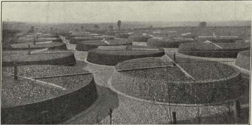
Fig. 85c. Ansicht der Wilmersdorfer Tropfkörper (in Stahnsdorf).
