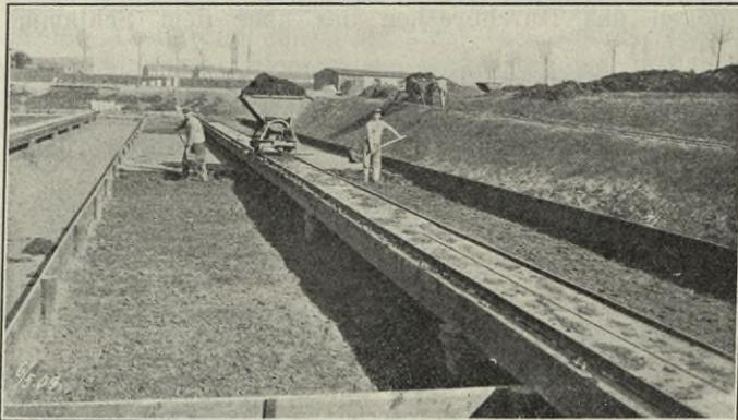
Fig. 98. Abstechen und Abfahren des getrockneten Schlammes.
