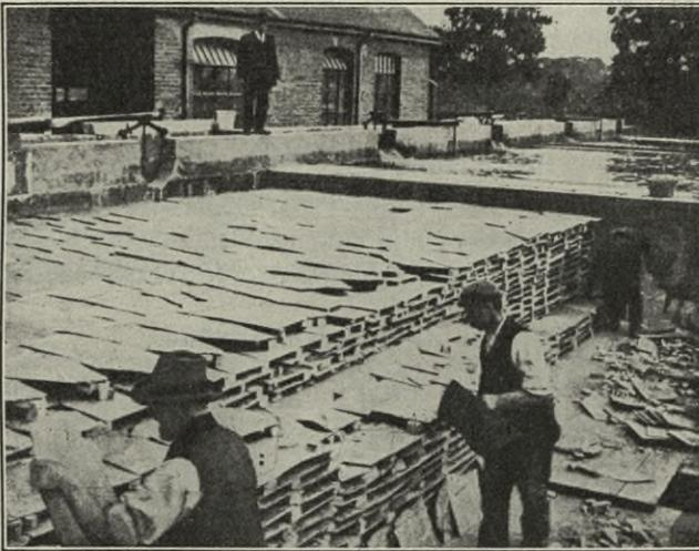
Fig. 76. Dibdins Schieferplattenkörper in Maldon (Surrey) im Bau.
