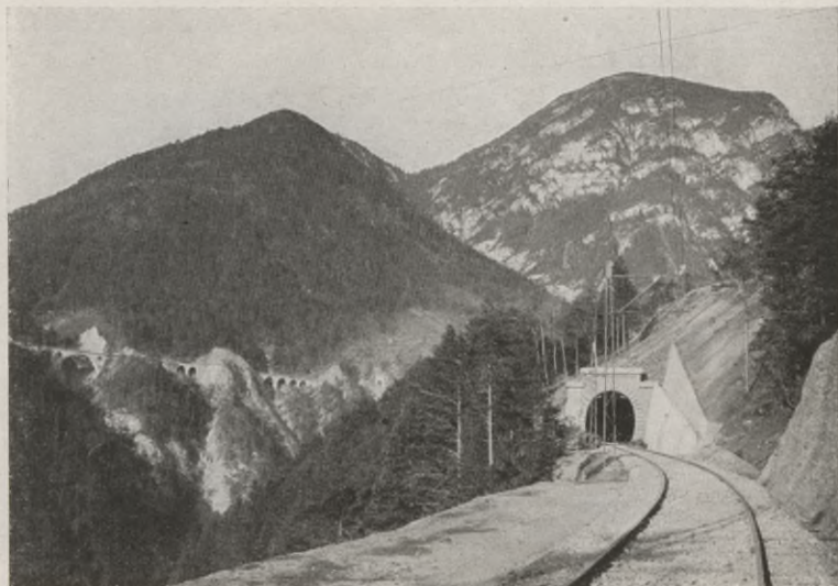
Vorbergtunnel Nr. 4 mit Blick auf die Terrassen bei Leithen.
