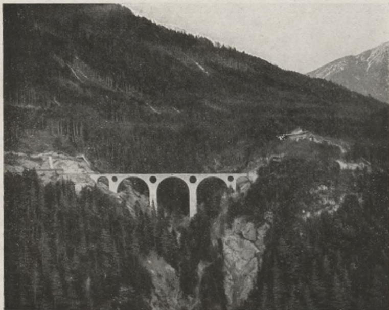
Vorbergviadukt vor Hochzirl.
