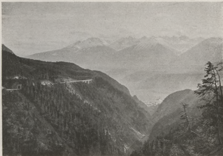
Blick von der Terrasse bei Leithen auf den Vorbergviadukt und das Inntal. Leonhard Misinato, Innsbruck phot.
