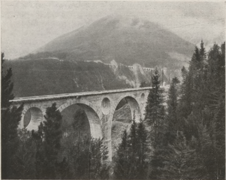
Vorbergviadukt mit Terrasse bei Leithen.
