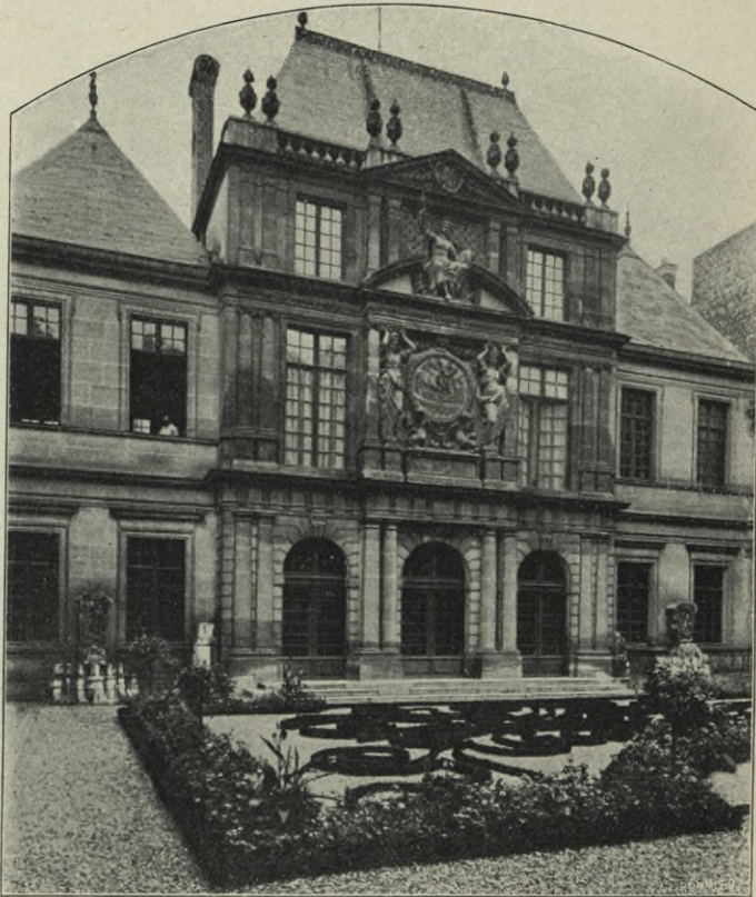
Abb. 61. Hotel Carnavalet. Fassade der Tuchhalle.
