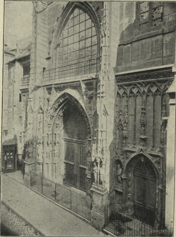
Abb. 34. Kirche St. Merry. Westfassade.
