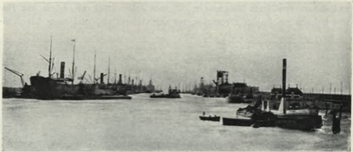
Der Außenhafen in Emden.
