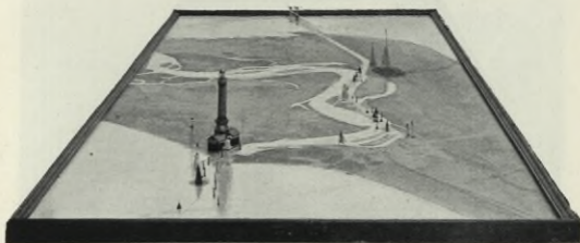
Beleuchtung der Wasserstraße Swinemünde-Stettin. Modell der Strecke Swine und Kaiserfahrt.
