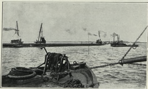
Der Königsberger Seekanal: Bau der Kanaldämme.
