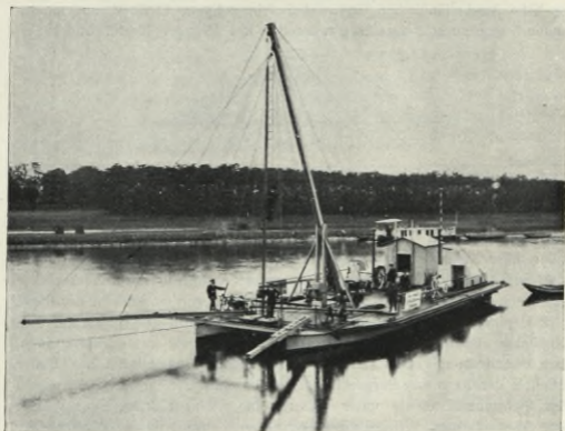
Meßvorrichtung zum Messen der Stromgeschwindigkeit.
