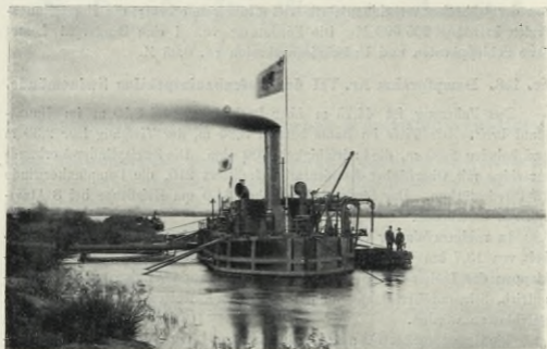
Das Spülpreßschiff der Elbstrombauverwaltung.
