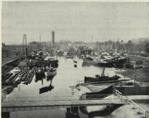
Ansicht des Bauhofes zu Swinemünde.
