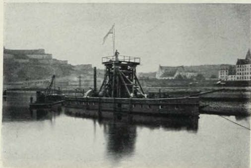
Taucherschacht der Rheinstrombauverwaltung.
