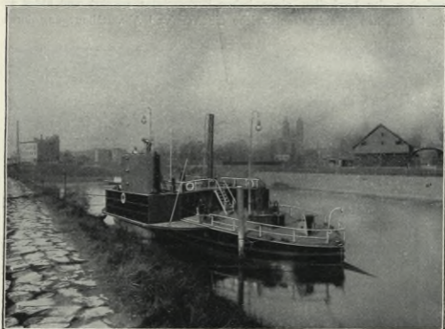
Taucherschacht der Elbstrombauverwaltung.
