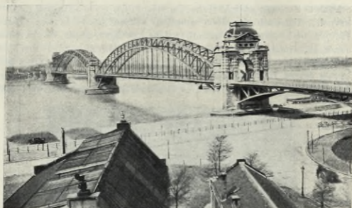
Die neue Rheinbrücke bei Düsseldorf.
