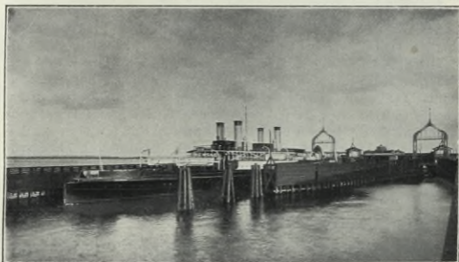
Ansicht der Anlegestelle von der Seeseite.
