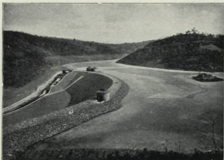
Talsperre bei Solingen. Staudamm mit Betonkern am Vorbecken. Winter 1901/02.
