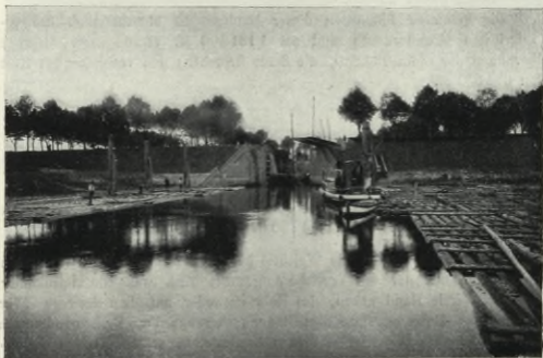
Die Hafenschleuse in Brahemünde.
