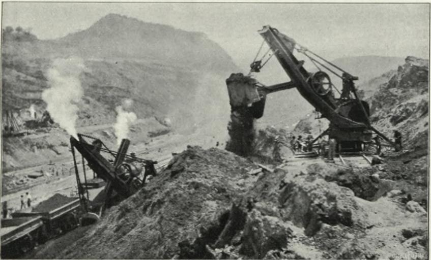
Abb. 21 (Kap. 5 c). Dampföffelbagger im Culebra-Einschnitt, im Begriffe eine Rutschung wegzuräumen und provisorisch abzulagern zur Bedienung des tiefer stehenden, den Materialförderzug ladenden Dampföffelbaggers. Okt. 1912.
