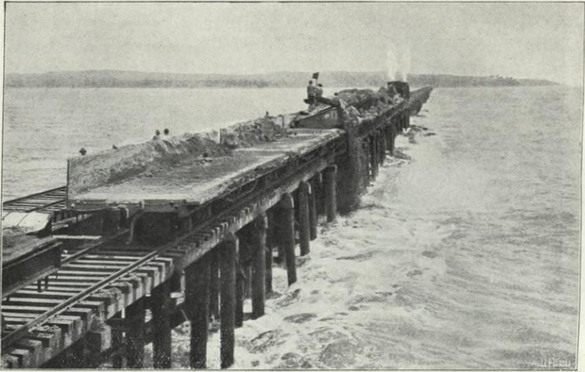
Abb. 29 (Kap. 6). Der Lidgerwood'sche «Unloader» oder Material=Abladepflug in Tätigkeit bei der Felsanschüttung für den Wellenbrecher bei «Toro Point» zwischen der Limon Bai und dem Caraibischen Meer. Blick in südwestlicher Richtung gegen den landseitigen Leuchtturm von «Pt. Toro» an der äussersten Nordwestecke der Kanal-Zone. Juli 1911.
