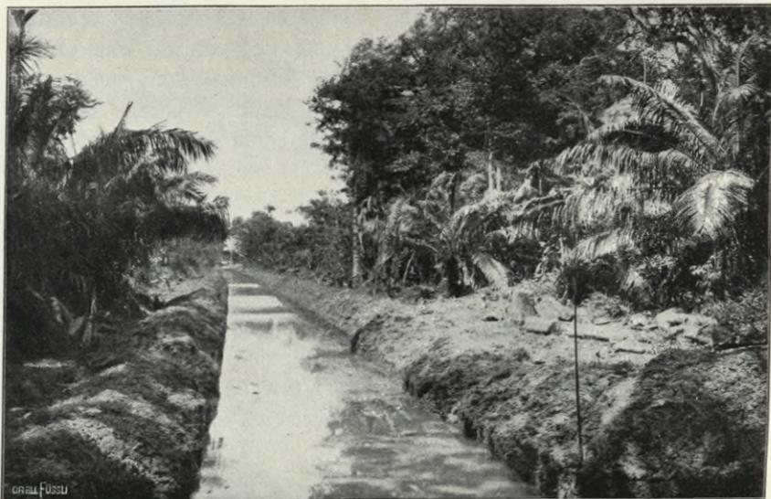
Abb. 22 (Kap. 5 d). Entwässerungsgraben No. 4 im tropischen Urwald zur Trockenlegung des Hinterlandes bei «Toro Point» (äusserste Nordwestecke der Kanalzone).
