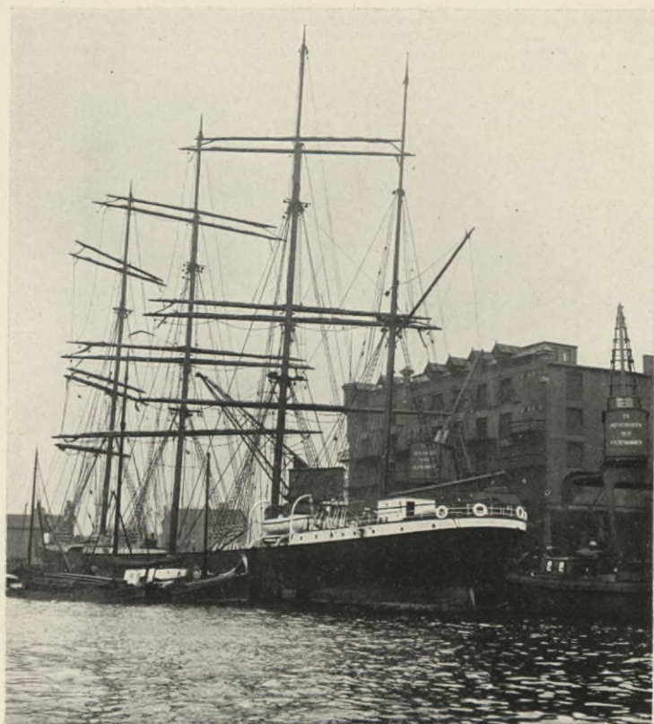
Lagerhaus „die Molukken“ der A.G. „Vriesseveem“ („Rijnhaven“)
