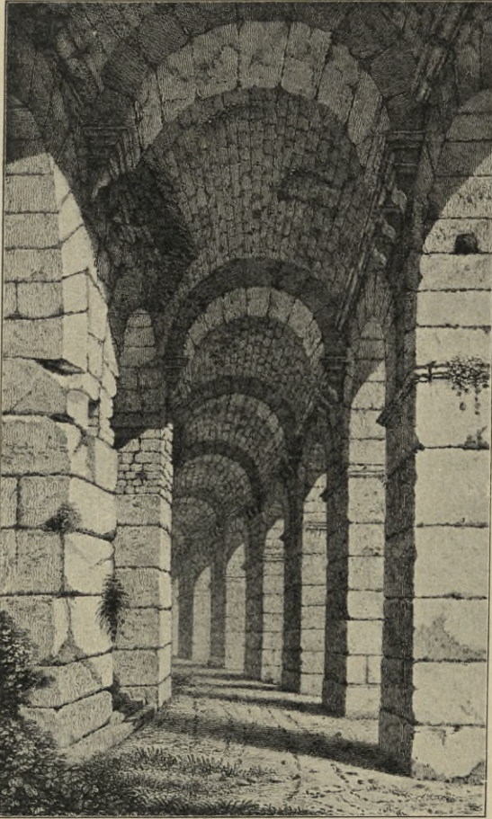
Abb. 181. Römisches Tonnengewölbe. (Gailhabaud, Denkmäler der Baukunst.)
