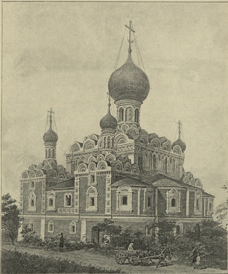
Abb. 257. Muttergotteskirche in Markowo, Aussenansicht. (Souslow, Ancienne architecture russe.)
