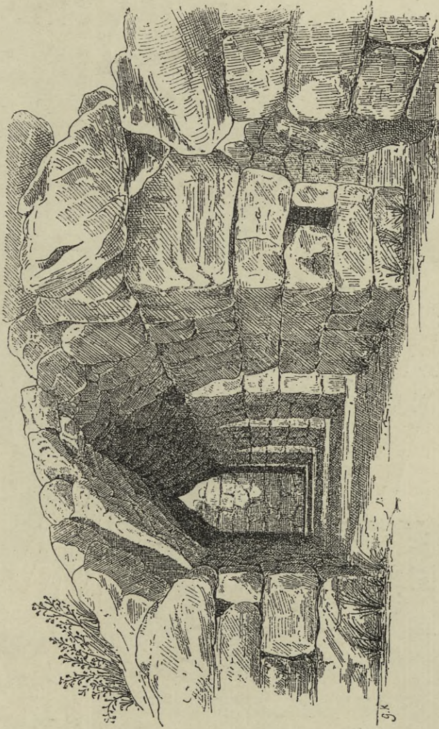
Abb. 105. Blick in die Galerie der Ostmauer. (Schliemann, Tiryns).
