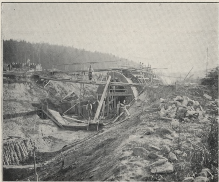
Bau des Durchlasses bei Ragösen.
