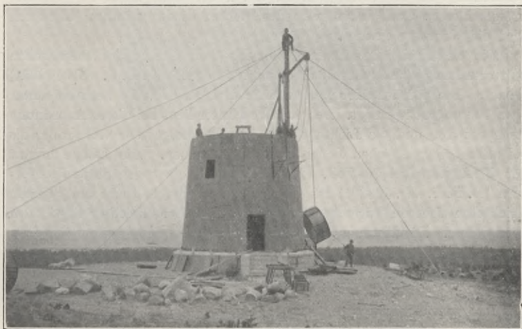
Leuchtfeuer Stilo im Bau.
