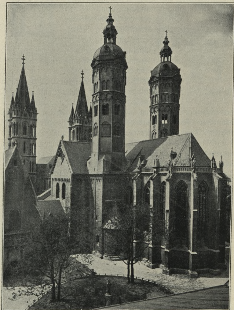
Abb. 84. Der Dom in Naumburg a. S. Links die Westtürme im Übergangsstil. In der Mitte das spätromanische Haupthaus. Rechts die romanischen Osttürme mit spätgotischem Abschluß und welschen Hauben sowie der gotische Ostchor.
