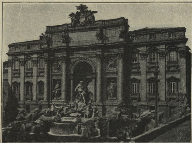
Abb. 249. Rom, Palazzo Poli mit der Fontana Trevi. Im 18. Jahrhundert nach einem Entwurf Berninis gebaut.
