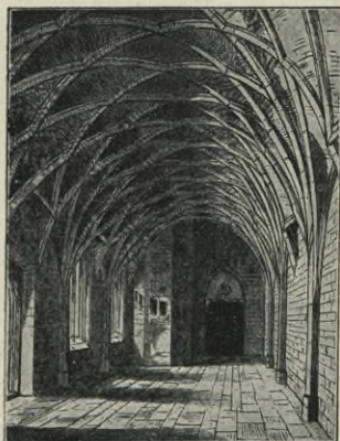
Abb. 100. Spätgotisches Gewölbe.
