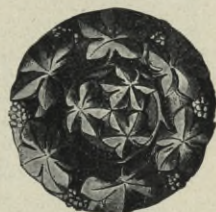
Abb. 91. Schlüsselstein eines gotischen Gewölbes (m. Weinlaub u. Trauben verziert).
