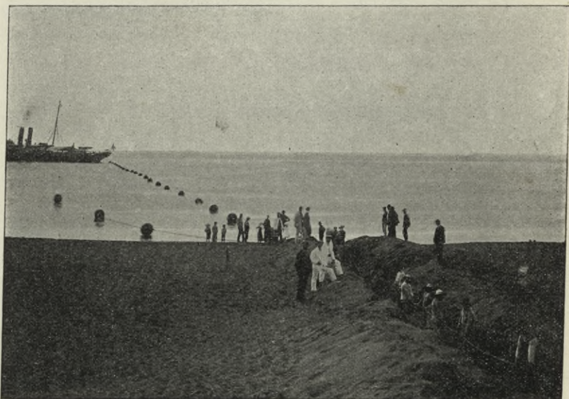
Eingraben des Kabels am Strande auf Fayal (1903).
