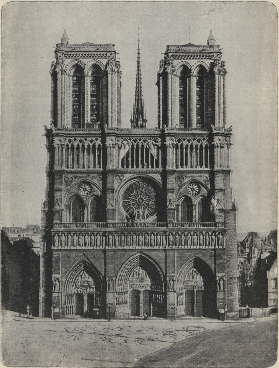
Fig. 207. Paris: Notre-Dame. Hauptfassade.
