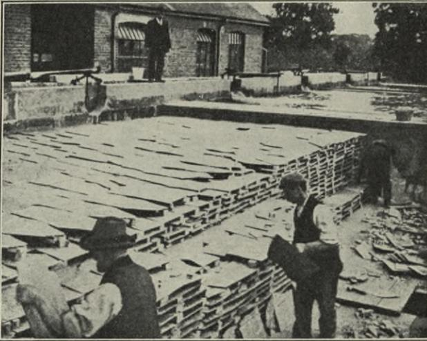
Fig. 28. Dibdins Schieferplattenkörper in Maldon (Surrey) im Bau.
