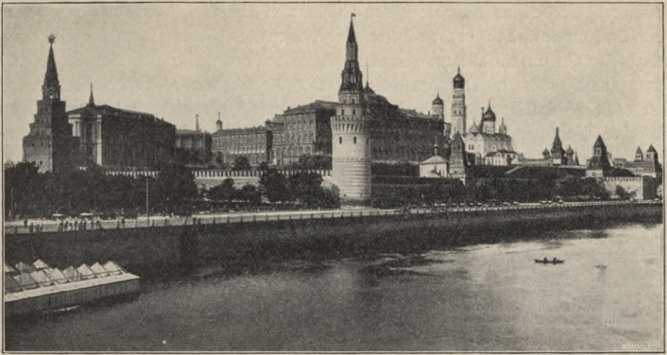
Abb. 1. Ansicht des Kreml von der südlichen Uferseite der Moskwa bei der steinernen Brücke.
