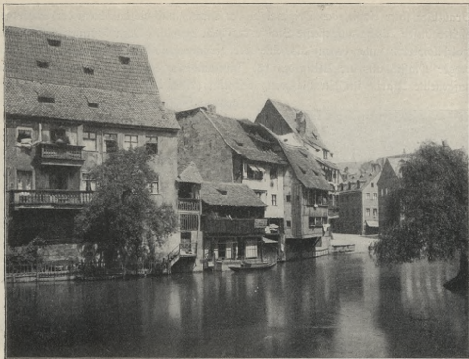
Abb. 48. Häuserpartie an der Pegnitz, gegenüber der Insel Schütt. (S. 78) Phot. von F. Schmidt.
