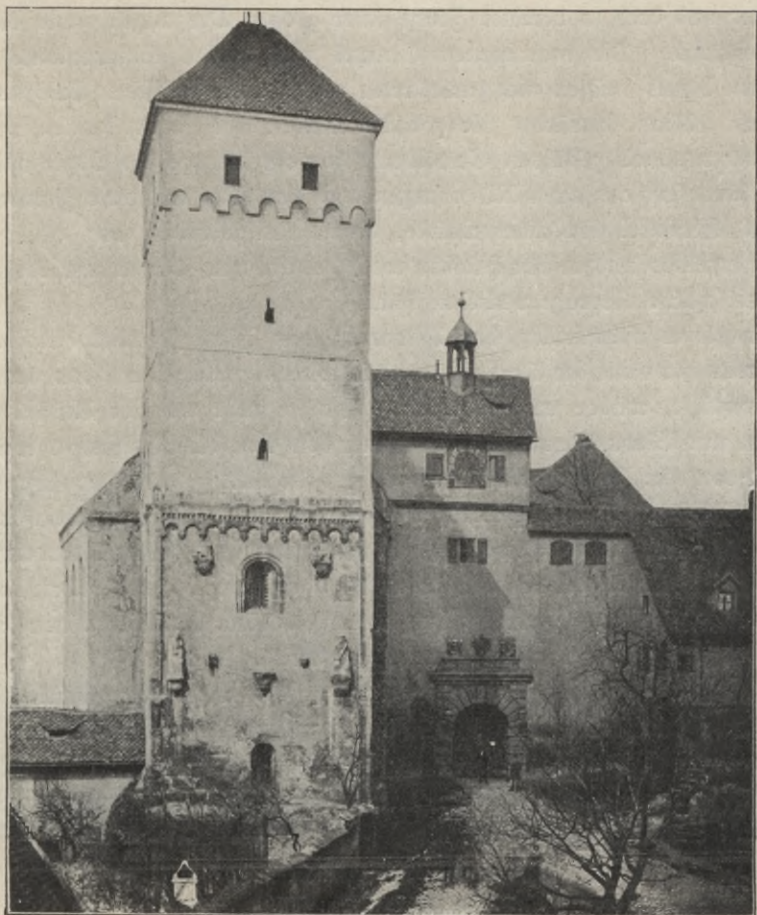
Abb. 2. Der Heidenturm an der Kaiserburg. (S. 7)
