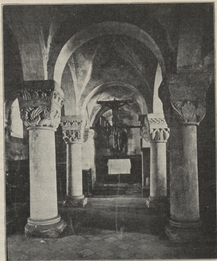
Abb. 9. Burgkapelle unterer Teil (Margaretenkapelle) (S. 16) Vor der 1892 erfolgten Erneuerung des Durchbruchs. Phot. von F. Schmidt.
