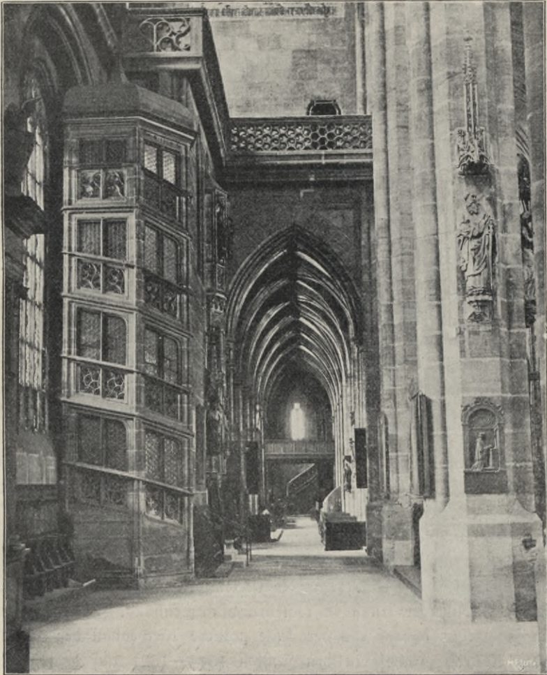
Abb. 40. Chor der Lorenzkirche mit Blick auf die Sakristeitreppe. Phot. von F. Schmidt.
