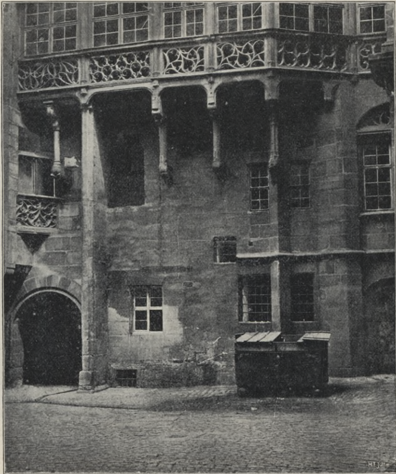
Abb. 43. Großer Rathauhof (Beheim'scher Teil). Phot. von F. Schmidt.
