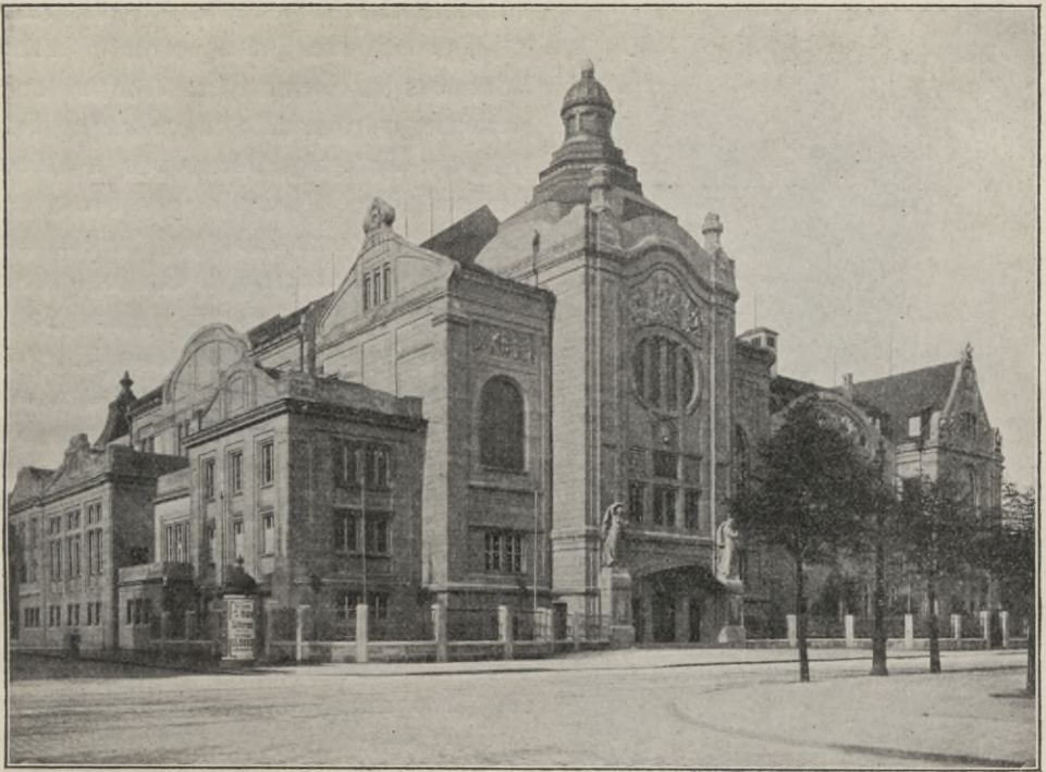
Abb. 170. Gebäude des Industrie- und Kulturvereins von Theodor von Kramer. Phot. von Ferd. Correll, Nürnberg.
