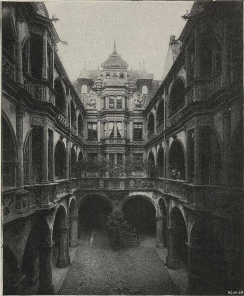
Abb. 143. Hof im Pellerhause. (S. 195) Phot. von F. Schmidt.
