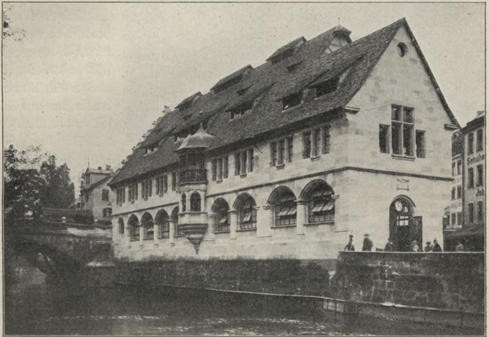
Abb. 162. Markthalle von Heinrich Wallraff. Phot. von F. Schmidt.
