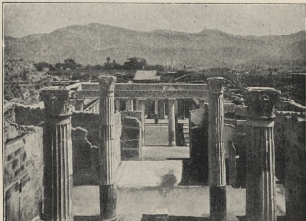
Fig. 111. Casa del Imperatore di Germania.
