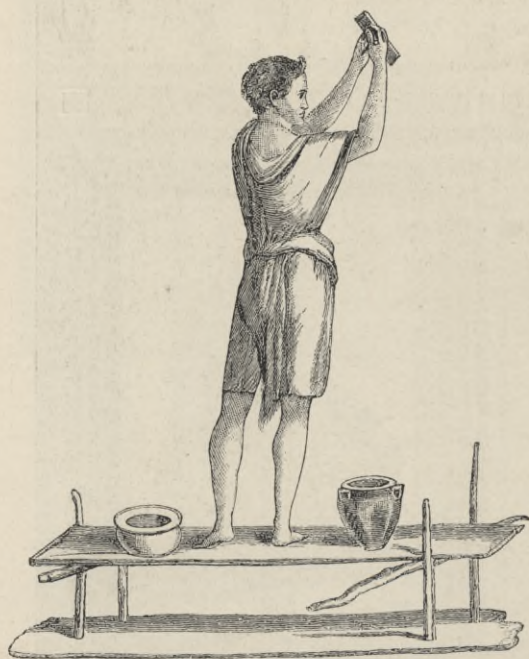
Fig. 66. Herstellung des Wandputzes.
