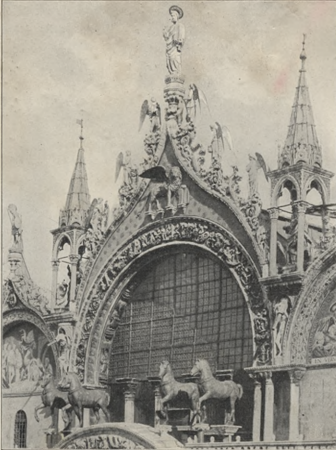
Fig. 15. Mittelgiebel an der Fassade der Markuskirche.
