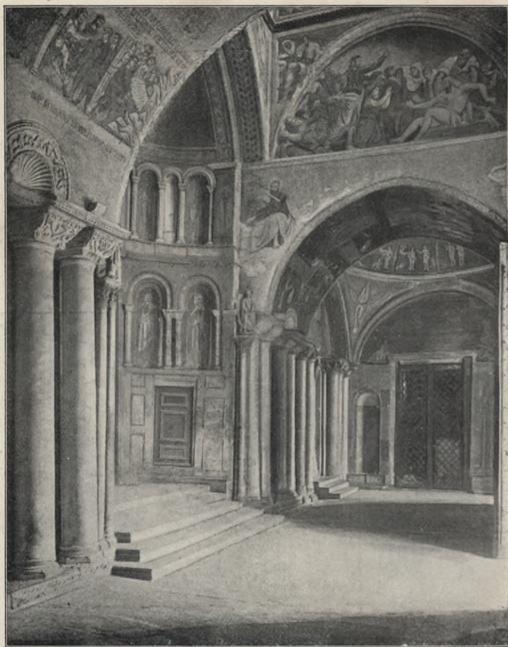
Fig. 16. Westliche Vorhalle der Marcuskirche.
