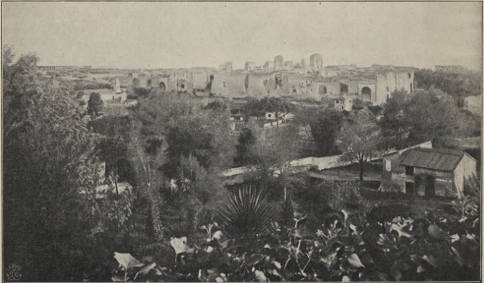
74. Caracallathermen. Gesamtansicht von Villa Mattei aus.
