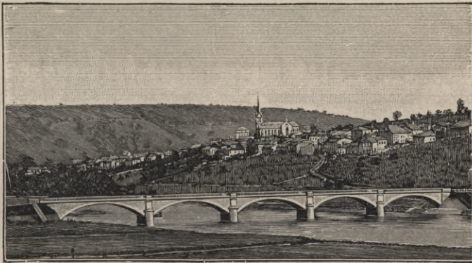
Fig. 153. Moselbrücke bei Sierdt.
