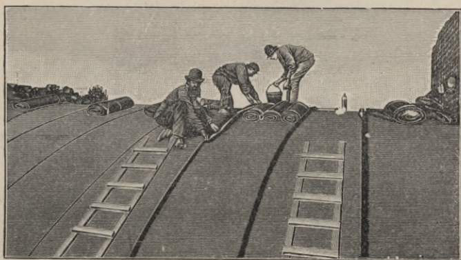
Fig. 151. Abdeckung eines Gewölberückens.
