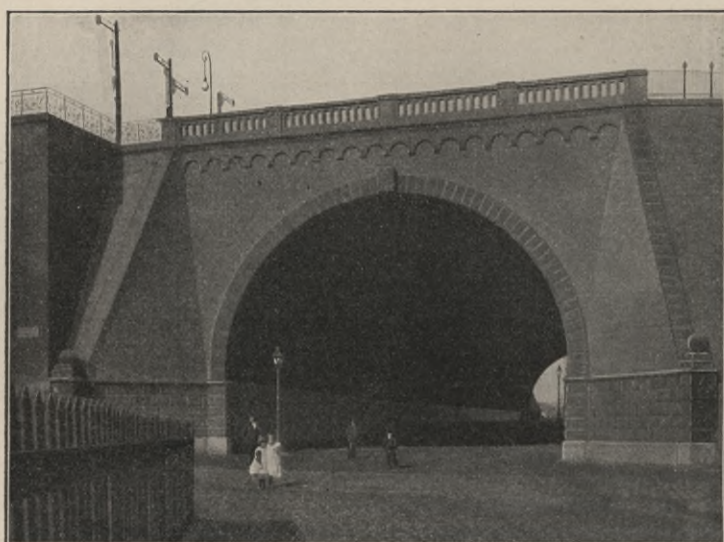
Fig. 121. Straßenunterführung in Essen.
