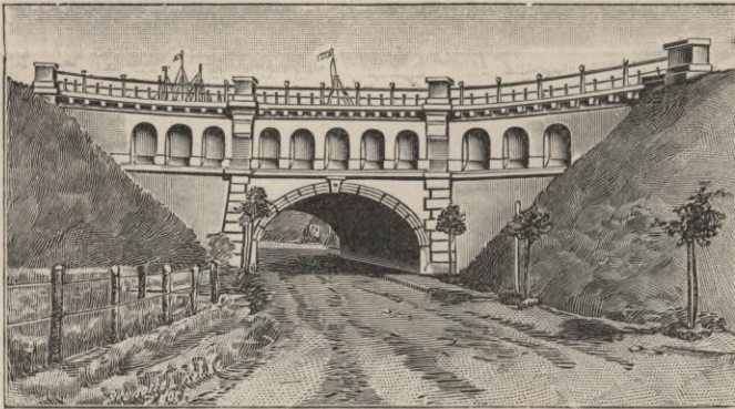
Fig. 186. Aquädukt im Dortmund-Emskanal.
