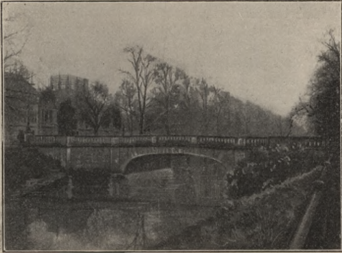
Fig. 101. Bevrather Brücke in Düsseldorf.
