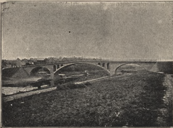
Fig. 162. Brücke mit Sparöffnungen.
