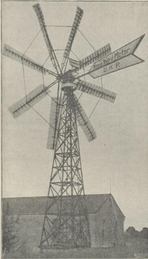
Fig. 392. Kegelwindmotor nach Sörensen.
