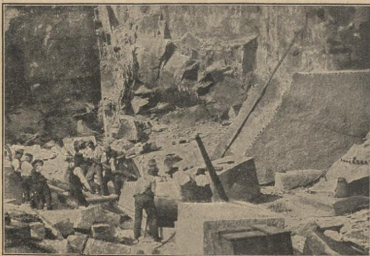
Fig. 7. Sandsteinbruch. Rechts das Abkeilen von Blöcken. Links Transport eines Blockes auf Holzwalzen.
