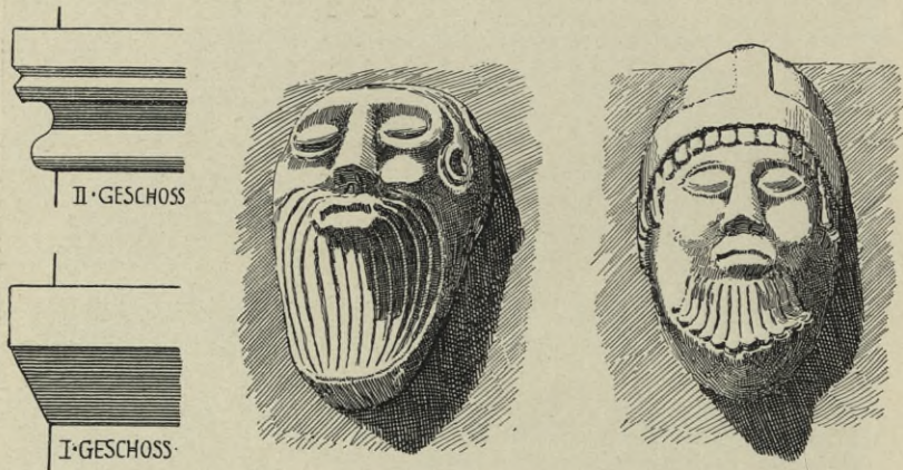
Fig. 17. Güntersleben. Details am Turm der Pfarrkirche.
