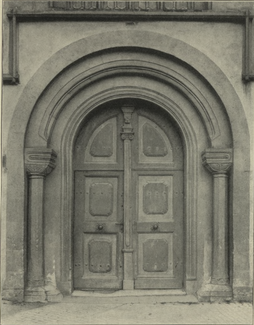
Fig. 24. Heidingsfeld. Nordportal der Pfarrkirche.
