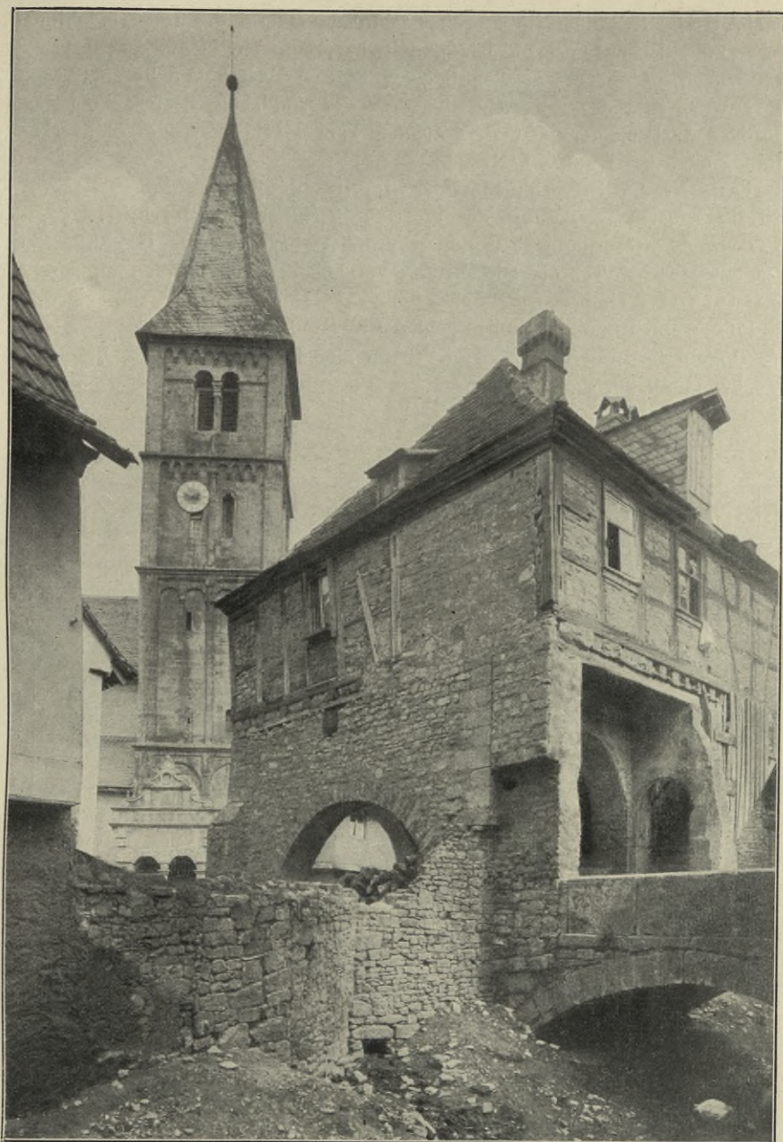
Fig. 80. Randersacker. Torhaus bei der Pfarrkirche.
