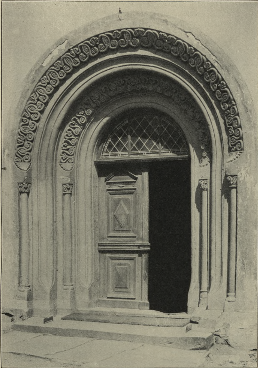
Fig. 70. Oberleinach. Portal der Pfarrkirche. Ansicht.
