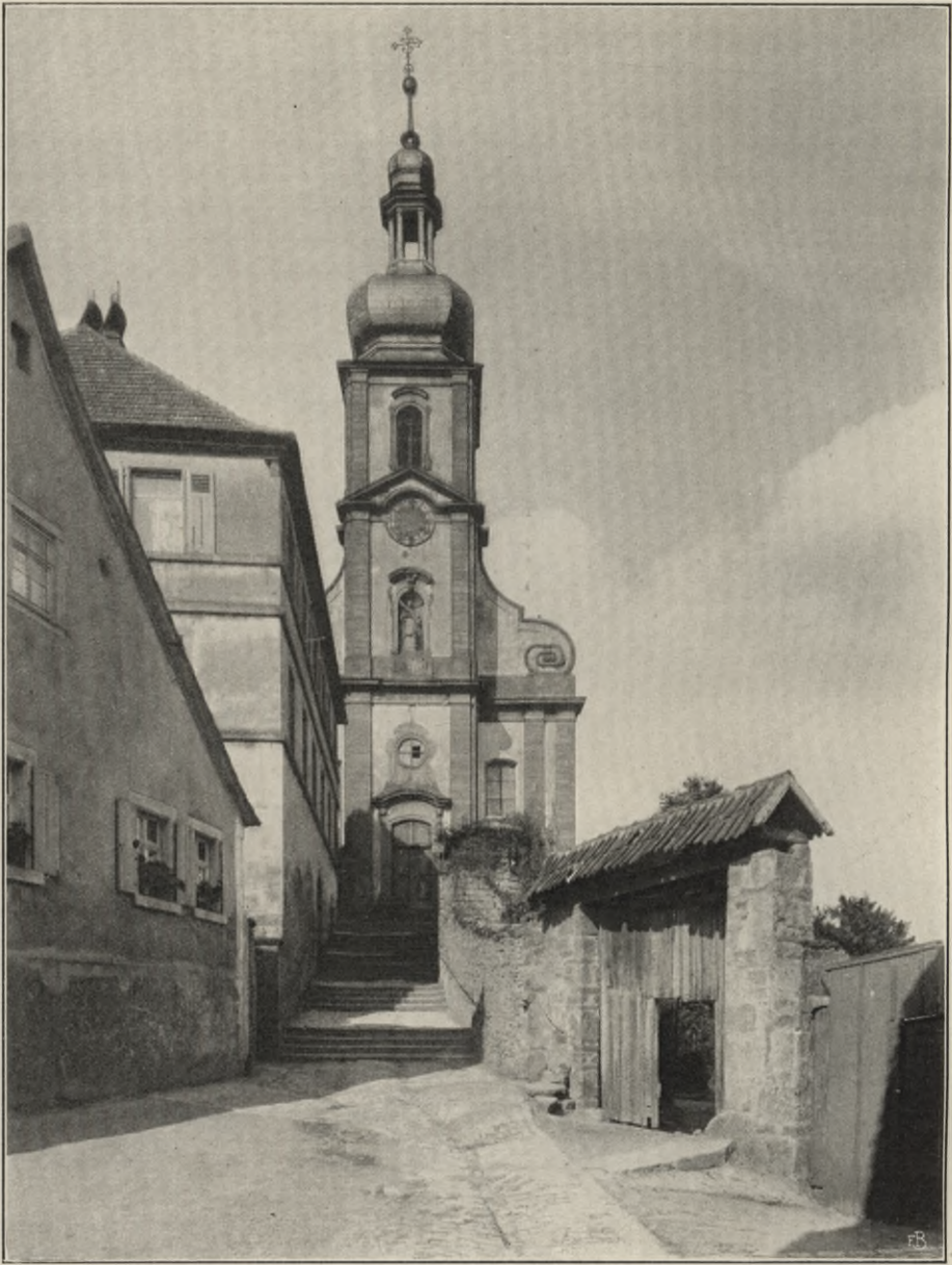
Fig. 93. Retzbach. Pfarrkirche. Ansicht von Westen.
