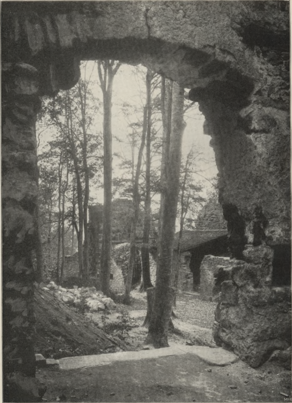
Fig. 19. Bramberg. Ansicht des Burghofes gegen Nordwesten.
