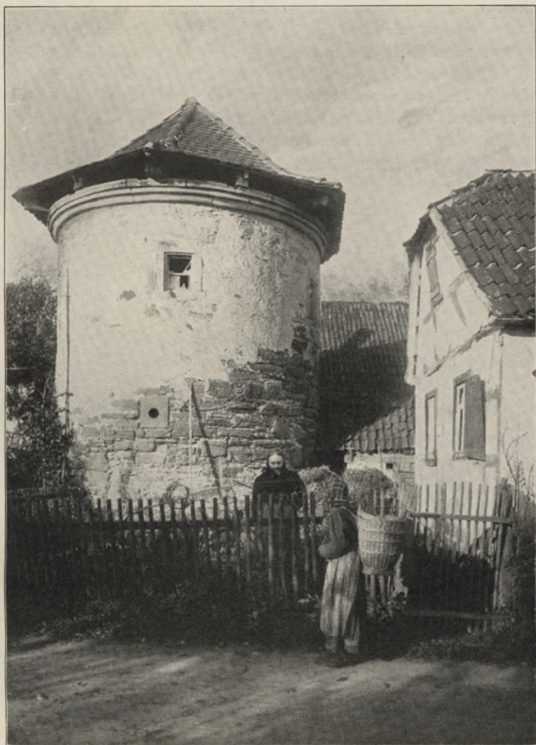
Fig. 42. Hofheim. Der »Dicke Turm«.
