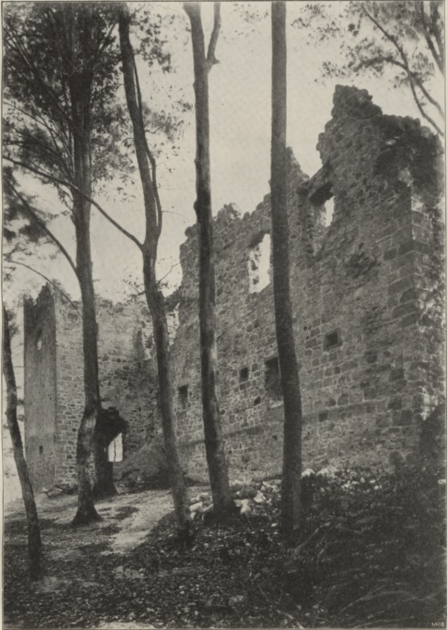
Fig. 18. Bramberg. Ansicht des Wohnbaues vom Hof aus.
