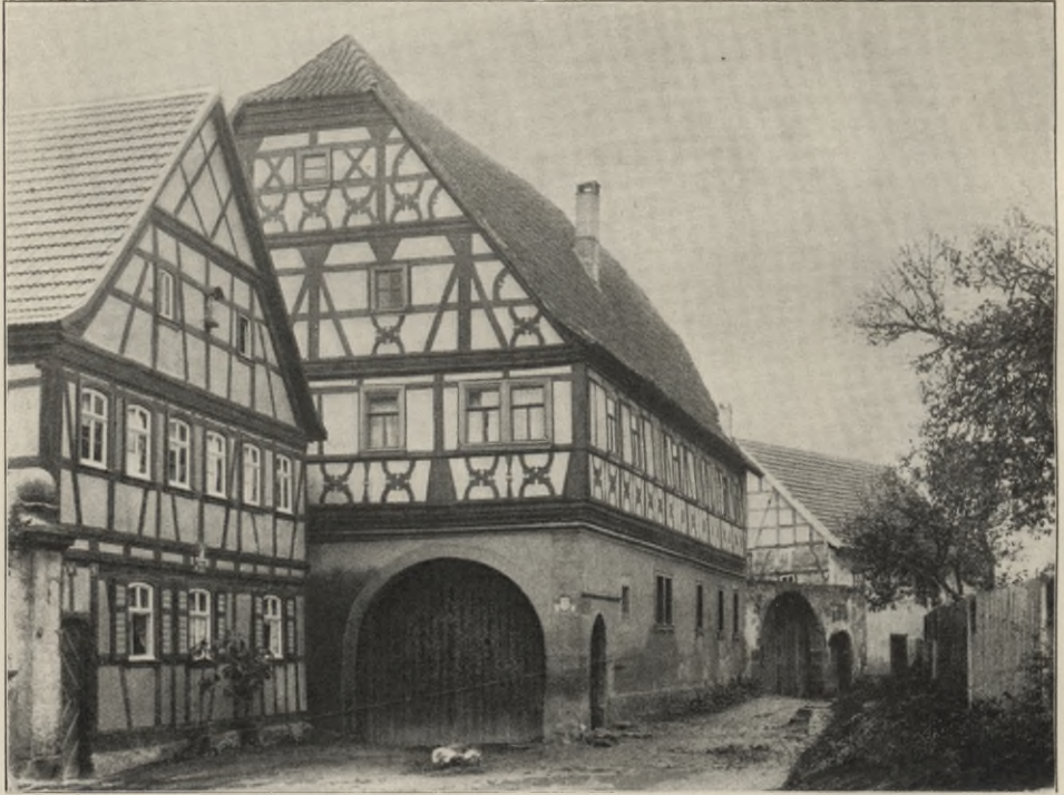
Fig. 34. Gößmannsdorf. Ehem. Vogteihaus.
