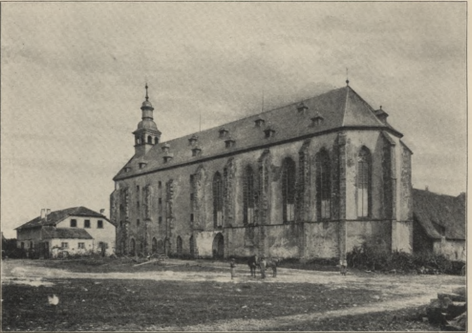
Fig. 72. Mariaburghausen. Ehem. Klosterkirche von Südosten.
