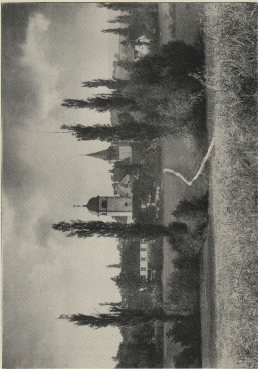
Fig. 107. Unterhohenried. Ansicht von Süden.
