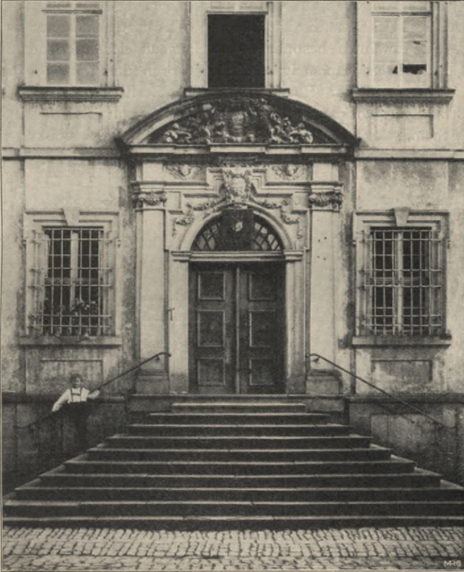
Fig. 54. Haßfurt. Bezirksamtsgebäude. Portal.
