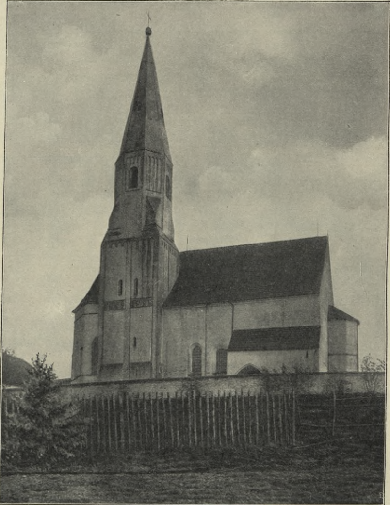
Fig. 77. Oberdingolfing. Ansicht der Kirche von Norden.
