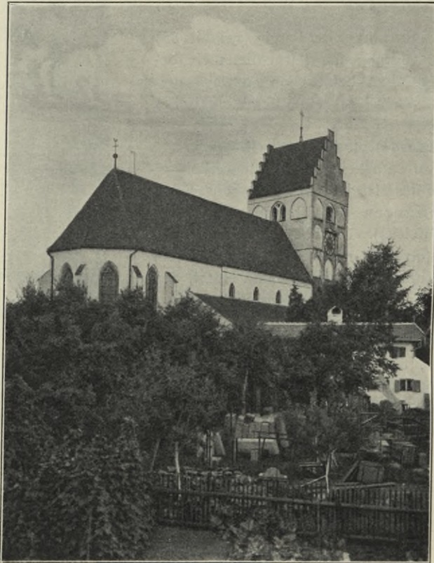
Fig. 88. Reibach. Ansicht der Pfarrkirche von Nordosten.
