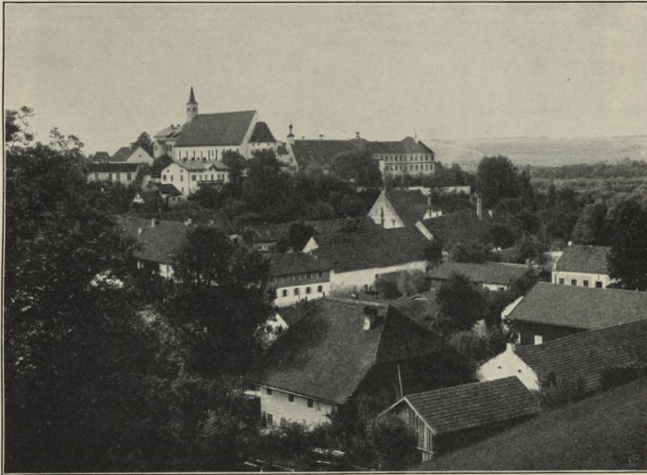
Fig. 64. Niederviehbach. Ansicht des Klosters von Südosten.
