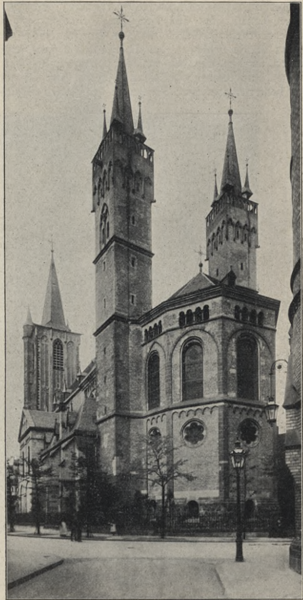
Fig. 50. Ostansicht von St. Severin.
