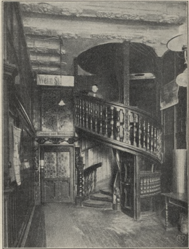
Fig. 148. Diele mit Wendeltreppe aus dem Haus zur Glocke am Hof.
